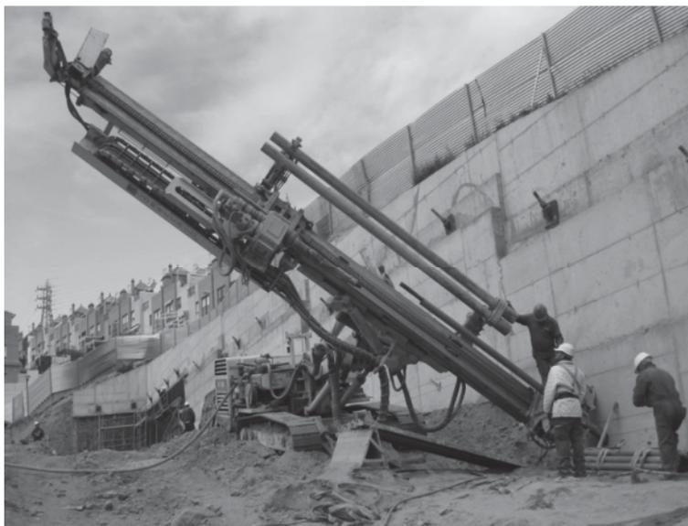
**Fig. 4** – Máquina perforando el taladro para instalar un anclaje
