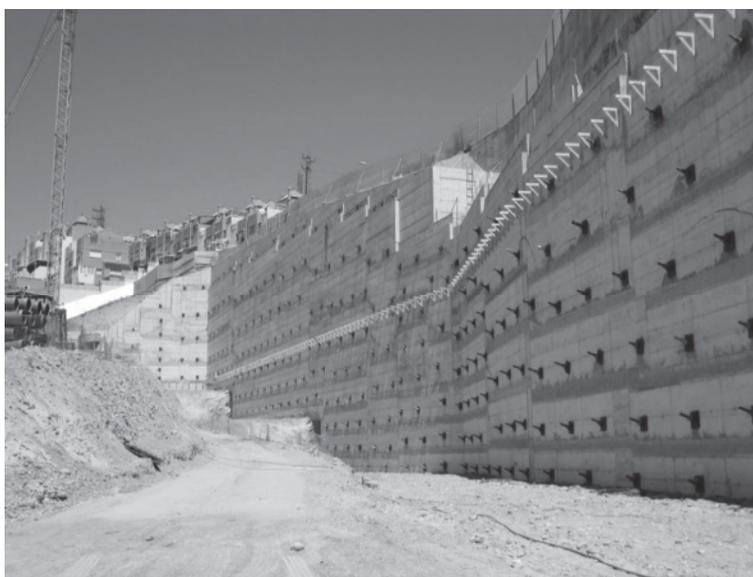
**Fig. 5** – Pantalla de micropilotes con todos los niveles de anclajes ejecutados
