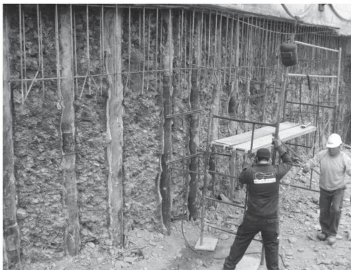
**Fig. 2** – Aspecto de la pantalla de micropilotes en un tramo en que se limpió el terreno para construir el forro exterior
