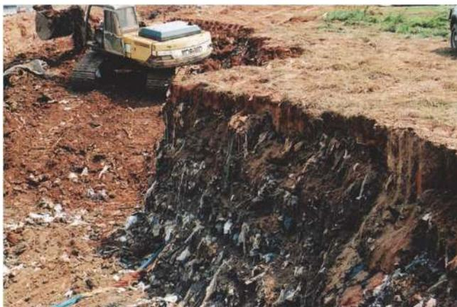
**Fig. 14** – Fase de escavação dos resíduos (Ford *et al.*, 2013).
