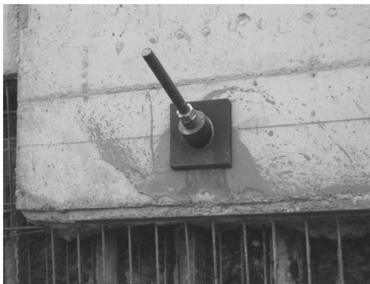
**Fig. 3** – Detalle de anclaje de barra y placa de anclaje
