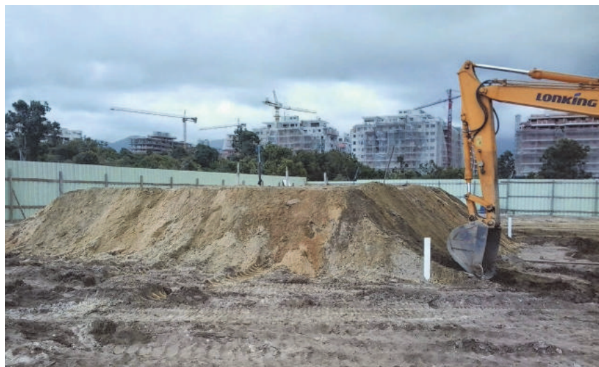
Fig. 14. Aterro teste finalizado, com os instrumentos instalados
