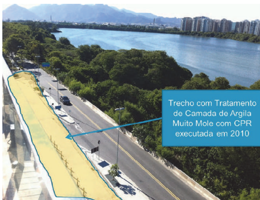
Fig. 2 – Área de tratamento de solo mole em trecho da Via de Acesso (Geoinfra, 2010)
