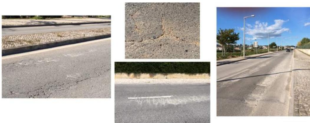
**Fig. 29** - Defeitos em pavimentos flexíveis associados às condições de fundação.
