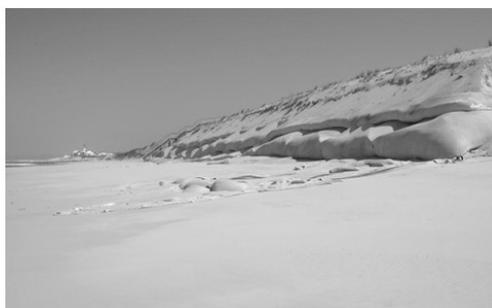
Fig. 19 – Instalação piloto de estrutura de proteção costeira em geo-sacos.
