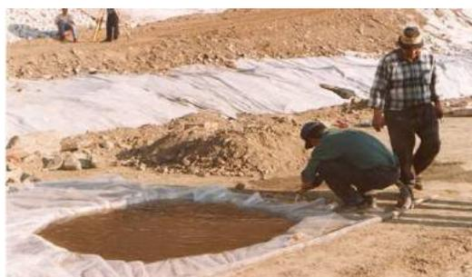
**Fig. 22** - Variante à EN 255, entre Borba e Vila Viçosa: aterros de enrocamento com blocos provenientes de escombreiras de mármore e determinação “in situ”.
