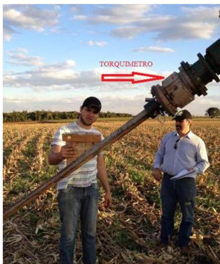
**Fig. 4** – Procedimento de instalação da estaca helicoidal
