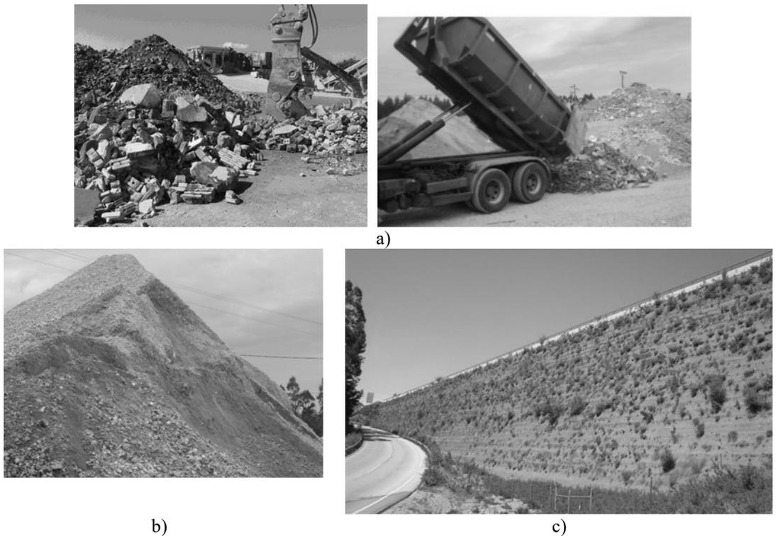
**Fig. 33** – a) Resíduos de Construção e Demolição; b) agregado reciclado; c) aterro reforçado com geossintéticos.
