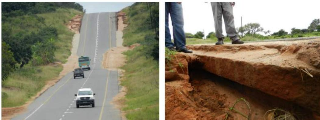
**Fig. 26** - Defeitos no pavimento resultantes de insuficiência no sistema de drenagem.
