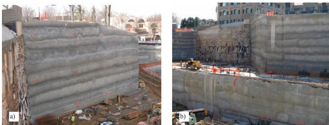
**Fig. 9** – a) Secção correspondente à escavação superior (exterior) mais profunda (19,8m);
