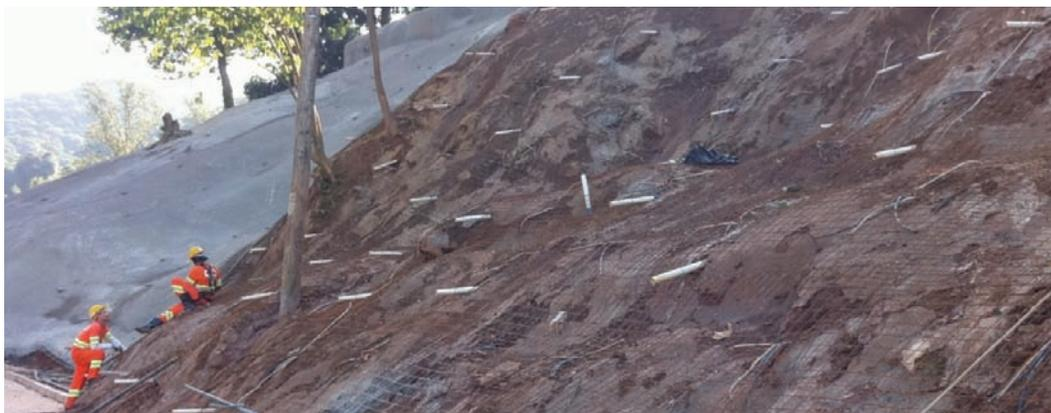
**Fig. 9** – Execução de solo grampeado.
