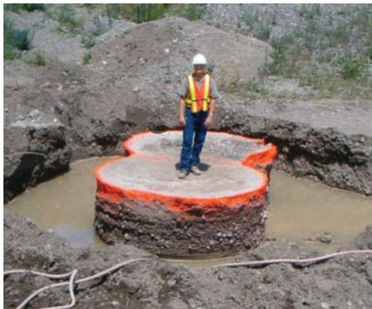
**Fig. 14** – Coluna construída por um método DMM
