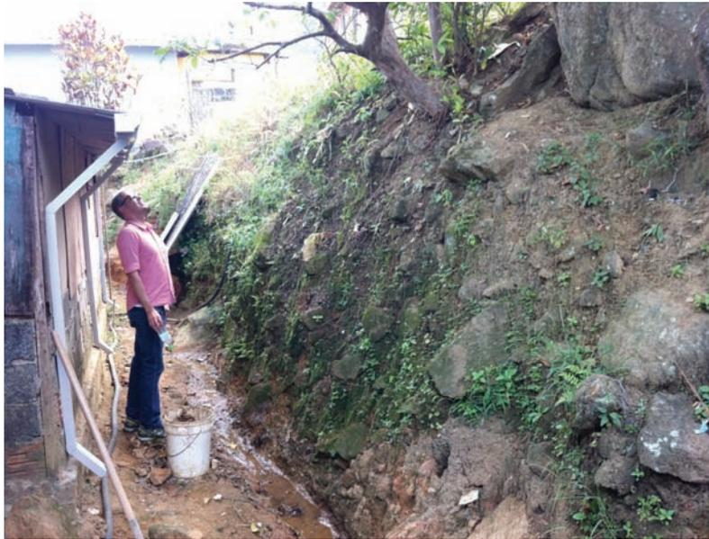
**Fig. 2** – Corte executado em tálus para construção de moradia.
