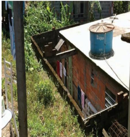
**Fig. 5** – Corte vertical e construção de muro de alvenaria como contenção.
