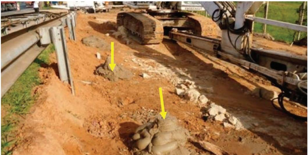
**Fig. 22** – Restos de graute posicionados nos locais de formação das colunas de injeção.
