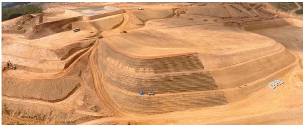
**Fig. 30** – Aterro reforçado com geossintéticos concluído.
