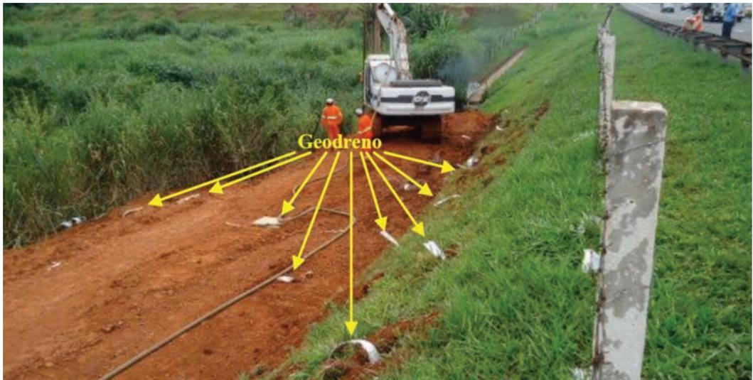
**Fig. 21** – Cravação dos drenos verticais geossintéticos.
