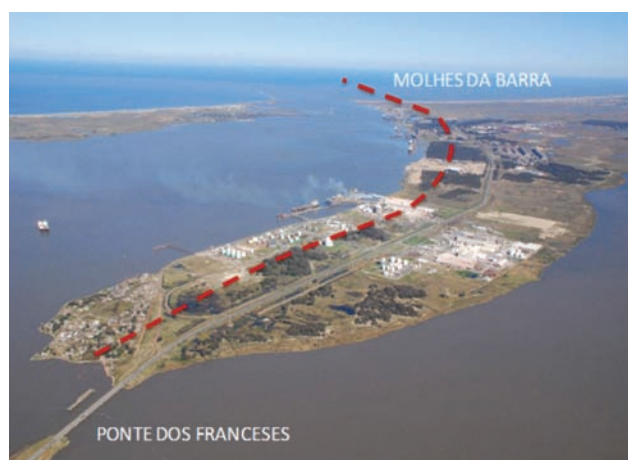
Fig. 2 – Vista geral do Superporto de Rio Grande.
