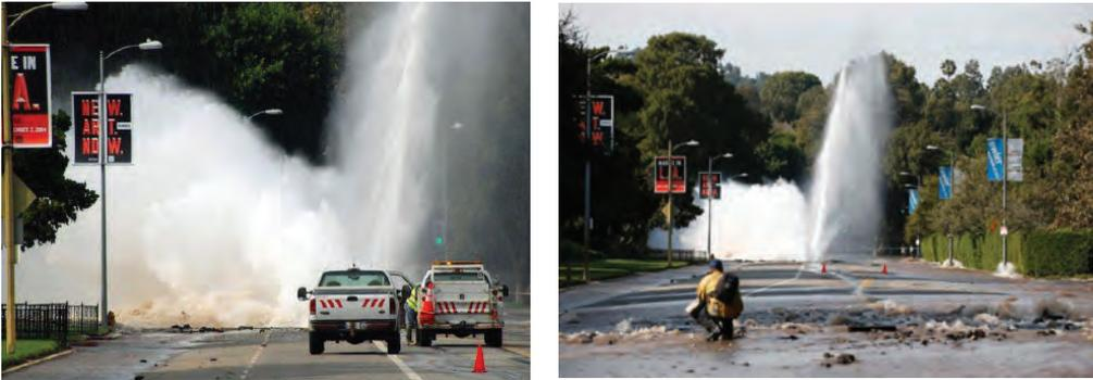
A ruptura de uma conduta de água com 0,75m de diâmetro em 29 de julho de 2014 no Sunset Boulevard, Los Angeles, originou os impressionantes jatos de água que se vêem nas fotografias. A enchente resultante (perderam-se mais de 75 milhões de litros de água) inundou várias áreas e edifícios da UCLA.
