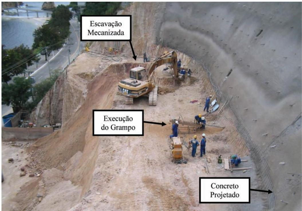
Fig. 2 – Processo executivo de contenção com solo grampeado (Sayão *et al.*, 2005).
