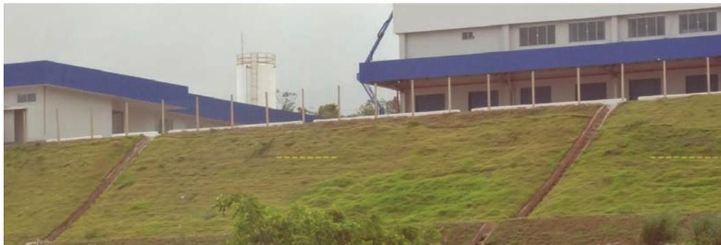
Fig. 2 – Na parte inferior da foto é observável deslizamento de solo na Formação Cabo (Kc).
