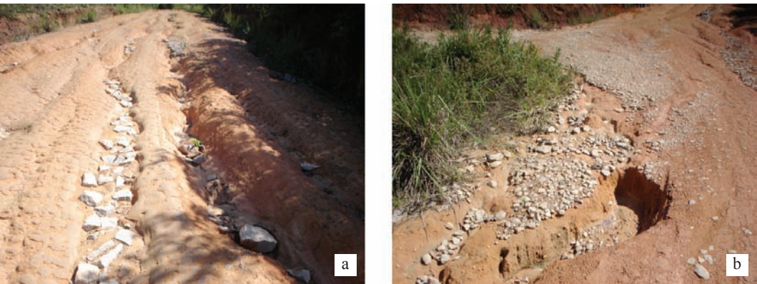
Fig. 1 – a) Agulhamento; b) Encascalhamento.
