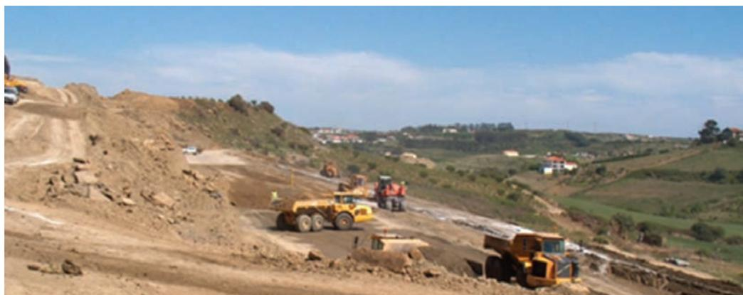
**Fig. 2** – Compactação de um aterro.
