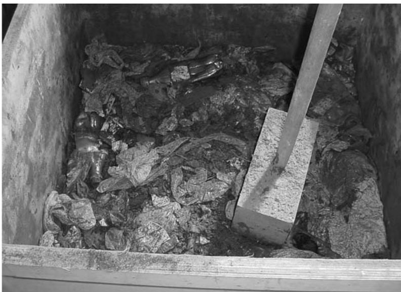
Fig. 5 – Compactação dos RSU em camadas.
