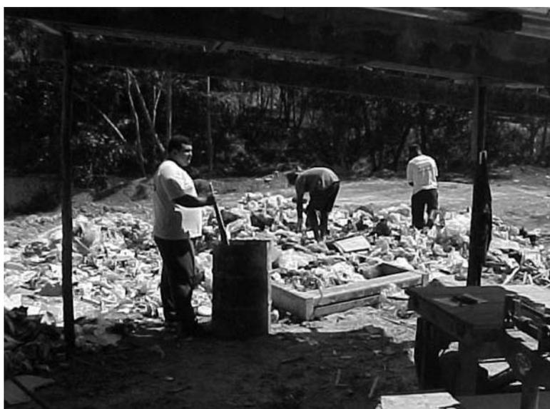
**Fig. 2** – Processo de quarteamento dos RSU para ser feita a gravimetria.
