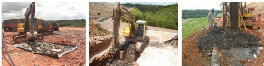
**Fig. 2** – a) Coleta de RN; b) Coleta de RV em cavas; c) Coleta de RV em perfurações a trado.
