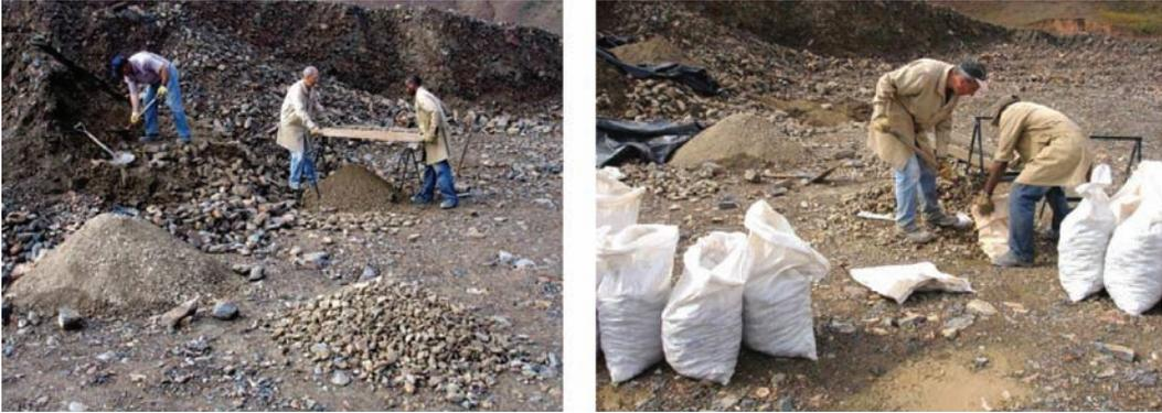
Fig. 12 – Processamento do material colhido da área de empréstimo.
