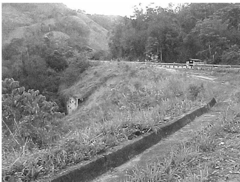
Fig. 6 – Cortina atirantada provisória em situação precária, km 379+500 – lado esquerdo.
