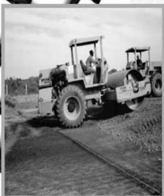
**A Huesker fornece a mais completa linha de geogrelhas, fabricada a partir de poliéster, polipropileno, PVA e aramida, específicas para cada tipo de aplicação.**
