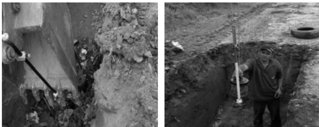
**Fig. 7** – Foto à esquerda: em destaque a cavadeira especial de extração;
