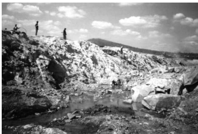
Fig. 6 – Face do Talude do Vertedouro no Bloco 03. Notar o contato entre os anfibolitos do Setor II-B-B3 e os granito-gnaisses do Setor II-D-B3.
