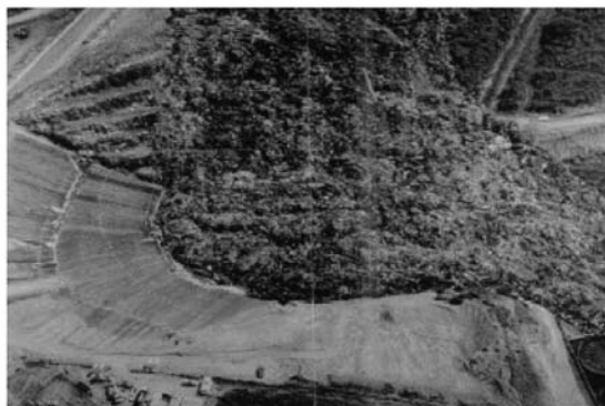
a) Aterro de Mobeni, África do Sul: rotura na interface argila/geotêxtil
