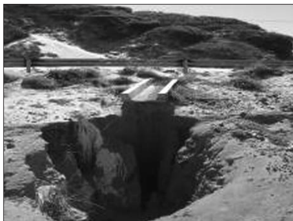
(b) Ravina provocada pela drenagem de rodovia adjacente a falésia
