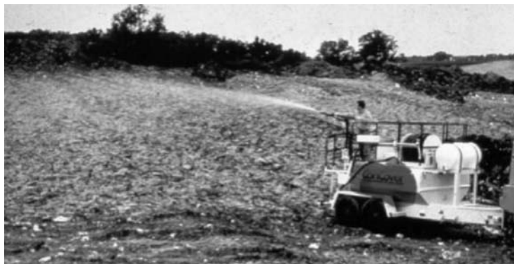
Fig. 18 – Adição de líquidos na frente de trabalho (Koerner, 2006).
