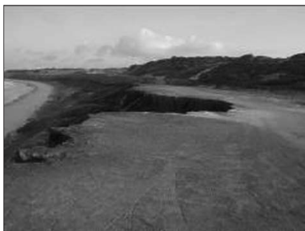
(c) Voçoroca no trecho sul
