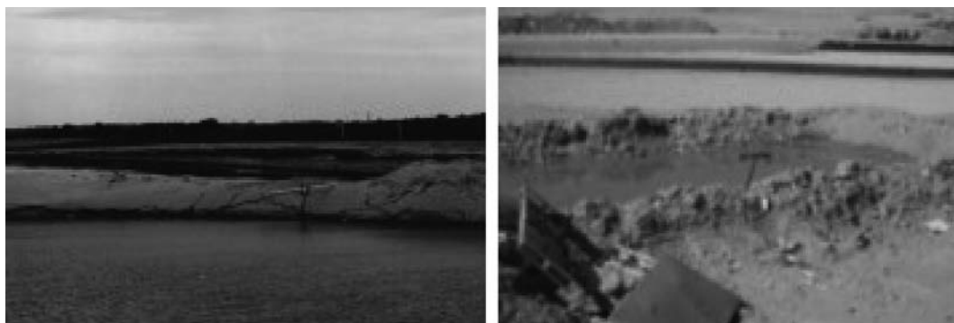
Fig. 7 – Recirculação de lixiviados: método de lagoas de infiltração (Reinhart, 2005 e Interstate Technology & Regulatory Council Alternative Landfill Technologies Team, 2006).
