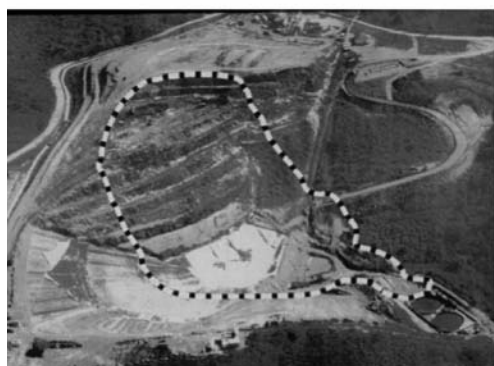
a) Aterro de Mobeni, África do Sul: rotura na interface argila/geotêxtil
