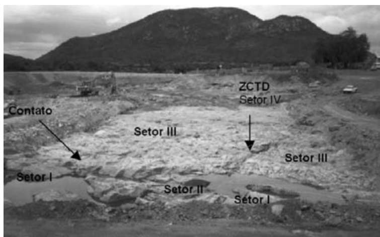
Fig. 3 – Visão panorâmica do canal da tomada d'água. Notar o contato e a diferença de coloração entre os gnaisses bandados e o granito-gnaiss pegmatítico, além dos diferentes setores estudados.
