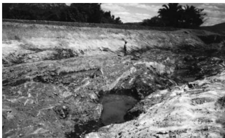
Fig. 8 – Maciço da margem esquerda. Notar a continuidade para jusante dos anfibolitos do Setor VI. Observar o expressivo controle estrutural e a ocorrência de água percolando no maciço.
