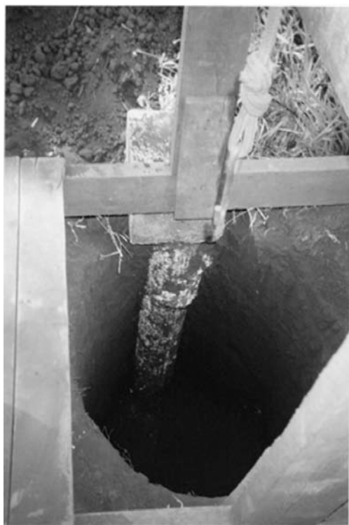
Fig. 11 – Inspeção in situ da ACL6(1).
