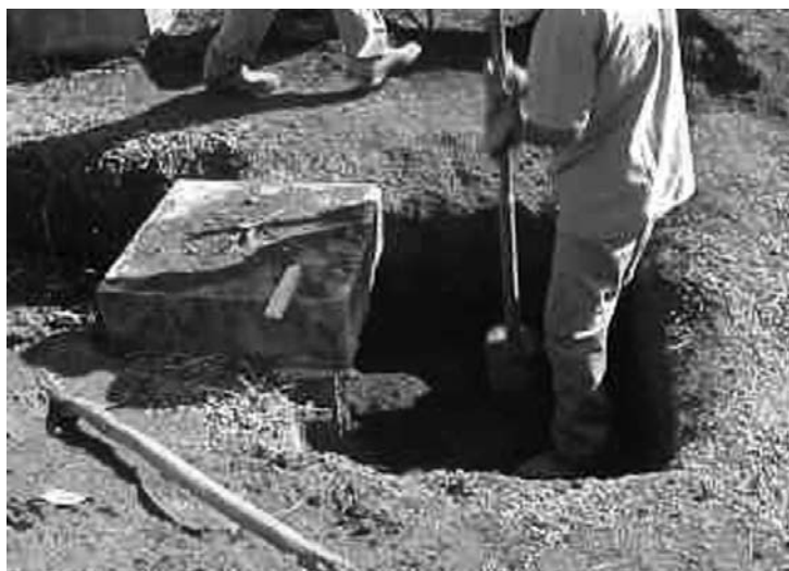
Fig. 6 – Preparação do solo-cimento compactado no campo.
