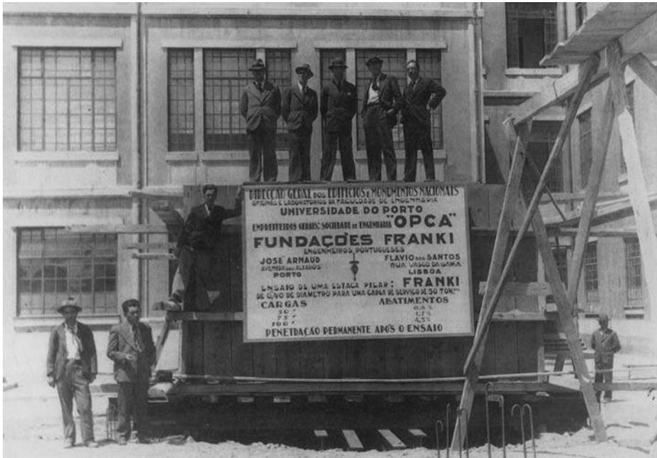
**Fig. 1** – Ensaio de estaca-pilar no Pavilhão das Oficinas e Laboratório da FEUP, Anos 30 (Lousada Soares, 1992).
