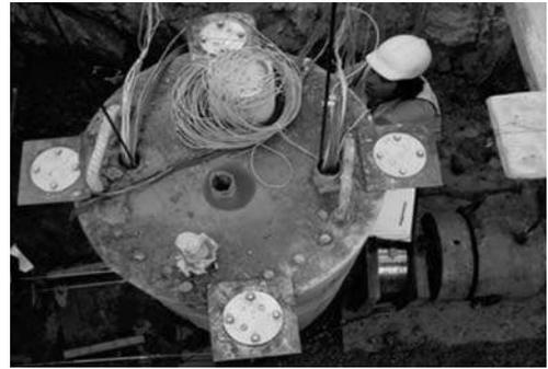
**Fig. 29** – Disposição do tubo do inclinômetro e das placas de apoio do clinômetro (Santos e Gouveia Pereira, 2005).
