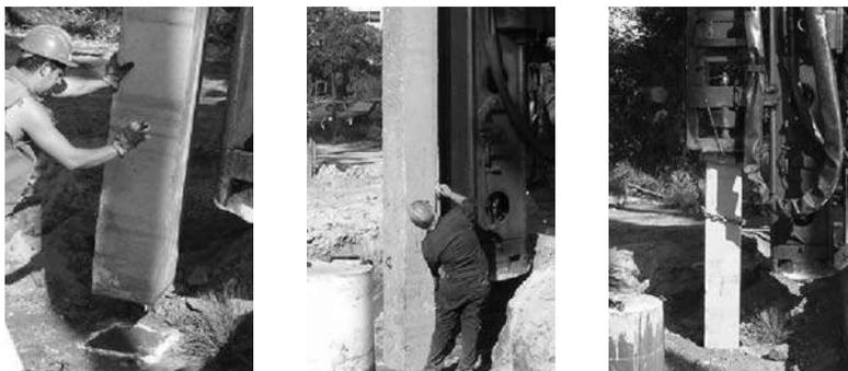
**Fig. 8** – Execução das estacas pré-fabricadas cravadas (Sopecate, SA).
