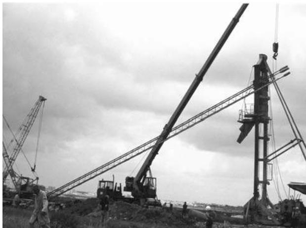
**Fig. 13** – Levantamento da treliça de amarração dos varões extensométricos e tubos de inclinómetro (Sousa Coutinho, 1995).
