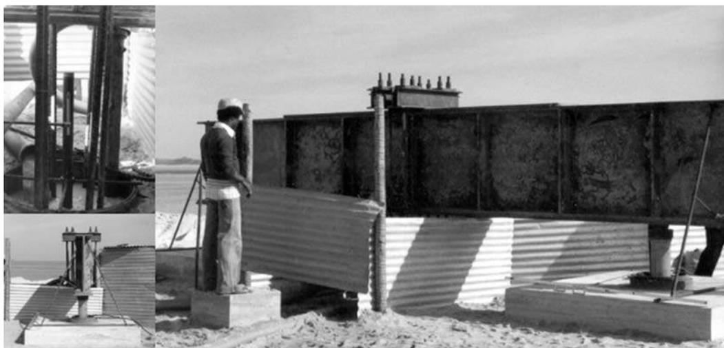
**Fig. 3** – Ilustração dos ensaios de estacas nas instalações da Quimigal (T. Duarte, 1981).
