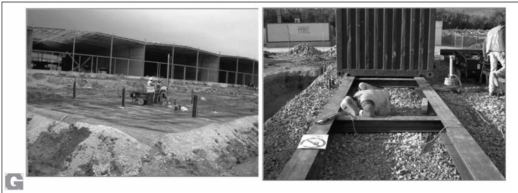
**Fig. 13** – Vista da colocação da última geogrelha e da instalação dos perfis HEB.
