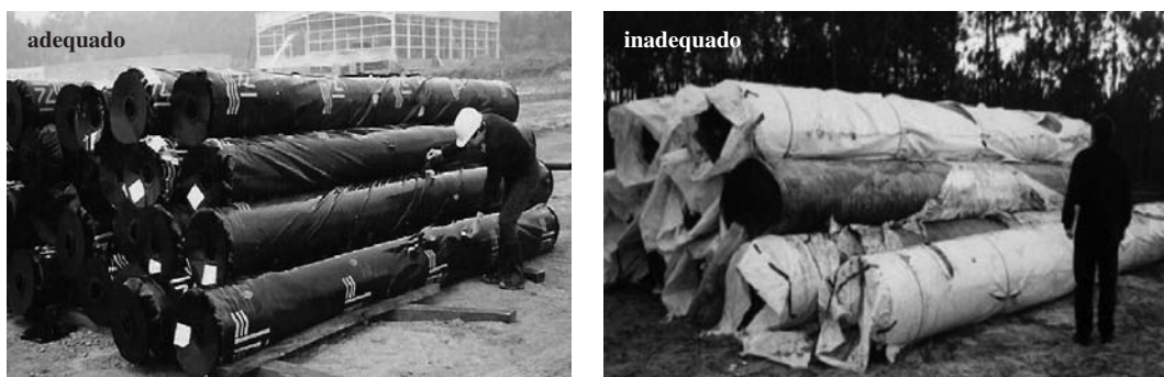
Fig. 3 – Exemplo de armazenamento temporário adequado e inadequado.
