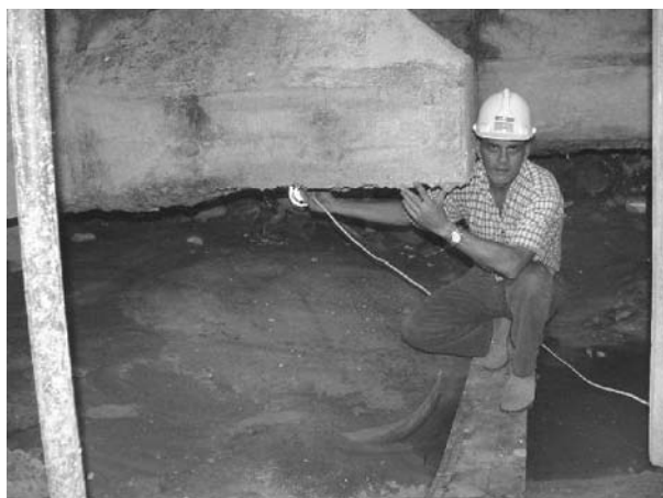
Fig. 20 – Sapatas escavadas.
