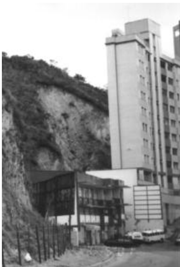
Fig. 2 – Vista geral do Talude Patagônia.
