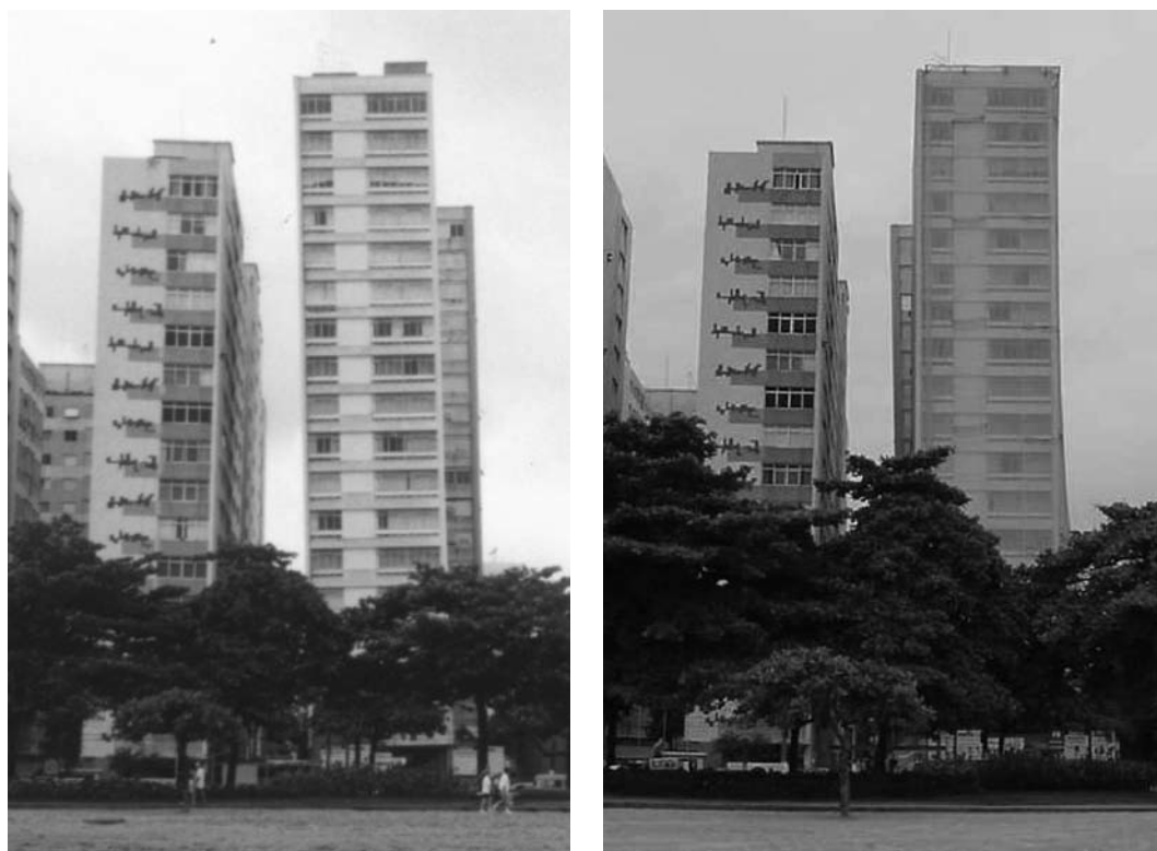
Fig. 26 – Edifício Núncio Malzoni antes e após o reaprumo.
