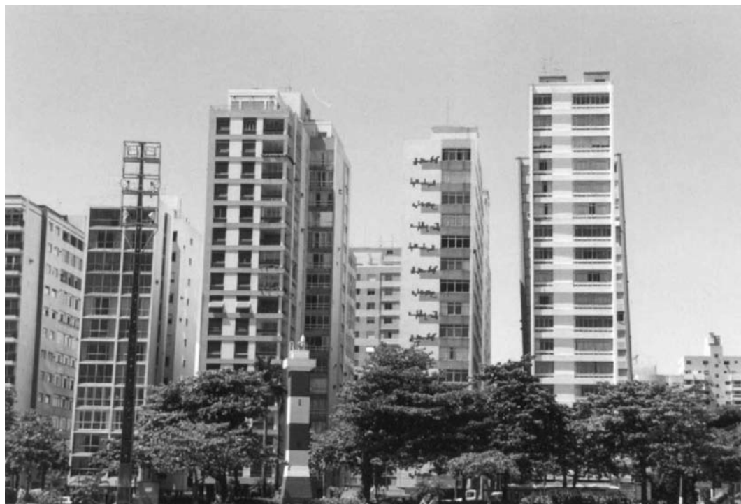
Fig. 4 – Foto mostrando o Bloco A do Condomínio Núncio Malzoni, após o reaprumo.
