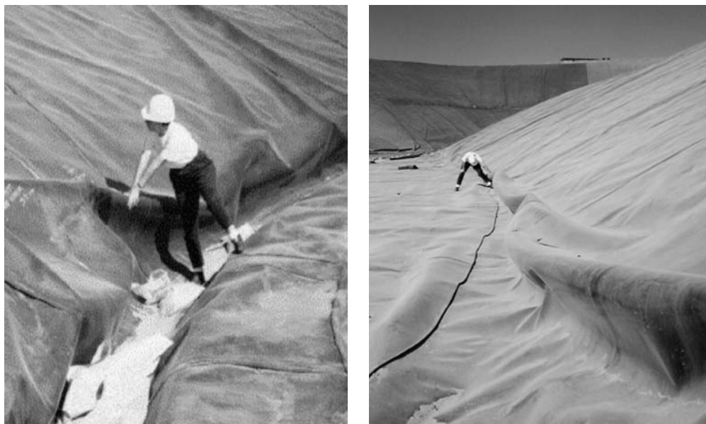
Fig. 8 – Dobras no pé de talude por insuficiente carregamento provisório (Lopes, 2000 a e b).
