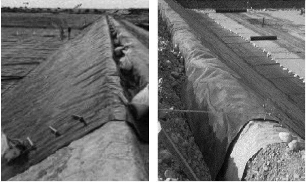
Fig. 9 – Carregamento provisório com sacos (a) e solo (b).
