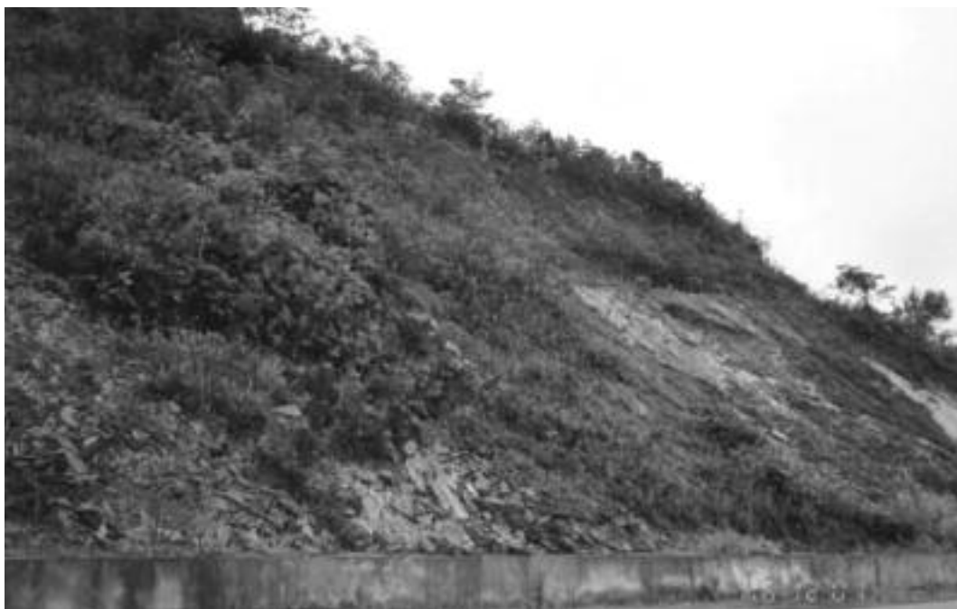
Fig. 15 – Vista geral do Talude Rio Acima, onde é possível visualizar o maciço e os depósitos de tálus.
