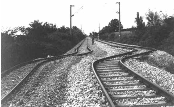
Fig. 37 – Deformação da plataforma e dos carris da via-férrea pelo deslocamento da falha. Sismo de Kocaeli (Turquia) de 17 de Agosto de 1999 [58].
