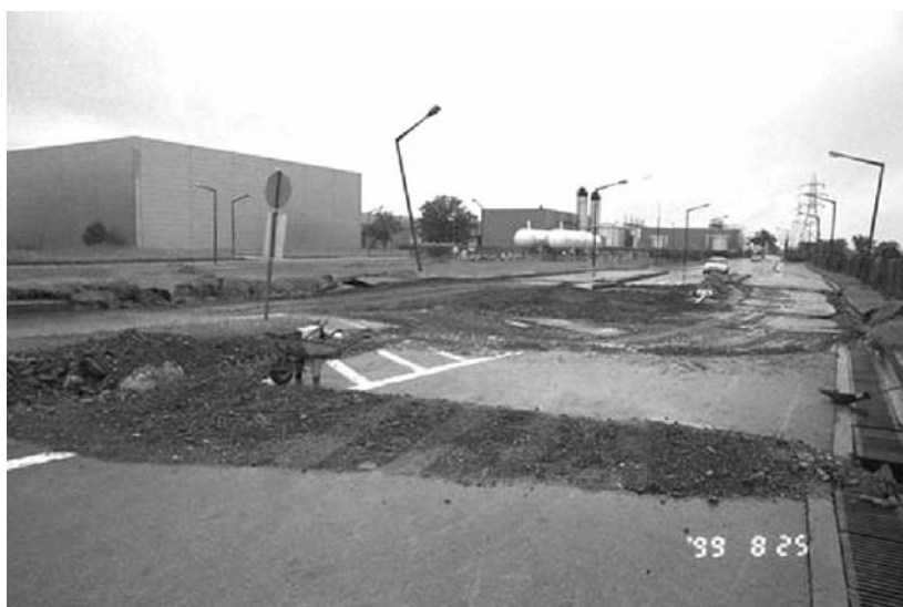
Fig. 36 – Danos numa auto-estrada devidos ao deslocamento da falha. Sismo de Kocaeli (Turquia) de 17 de Agosto de 1999 [57].
