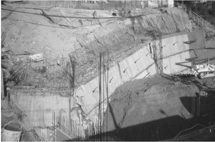
**Fig. 10** - Estrutura de contenção tipo Berlim após rotura.
