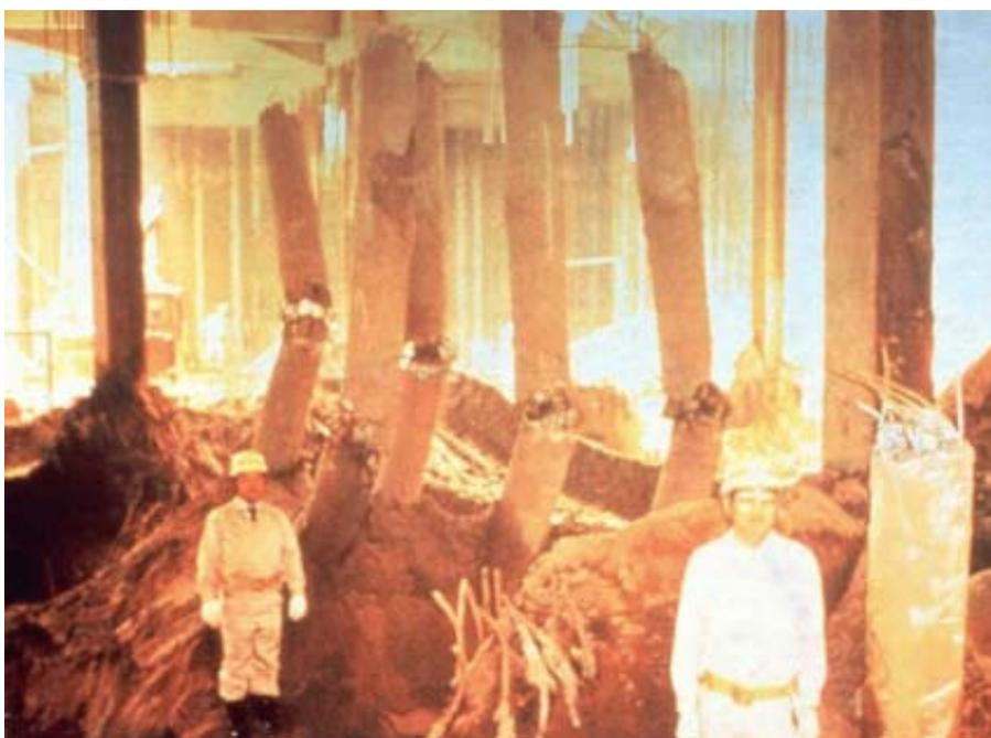
Fig. 24 – Rotura devido ao efeito de interação cinemática solo-estaca (Kobe 1995).
