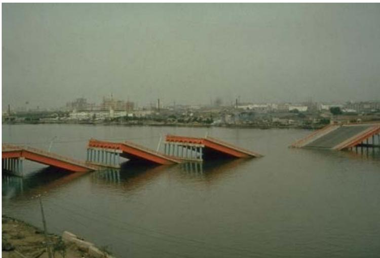
Fig. 22 – Colapso da ponte provocado pela liquefacção do solo (Niigata 1964).
