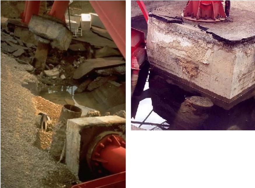
Fig. 21 – Colapso do terminal fluvial devido à rotura por corte das estacas (Kobe 1995).
