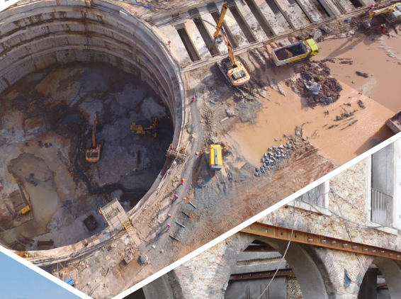
Poço de minério Kamsar, Guiné
