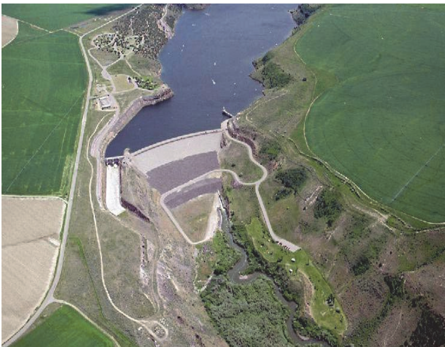
Fig. 9 – Vista geral da barragem de Teton no fim do primeiro enchimento (Maio de 1976)
