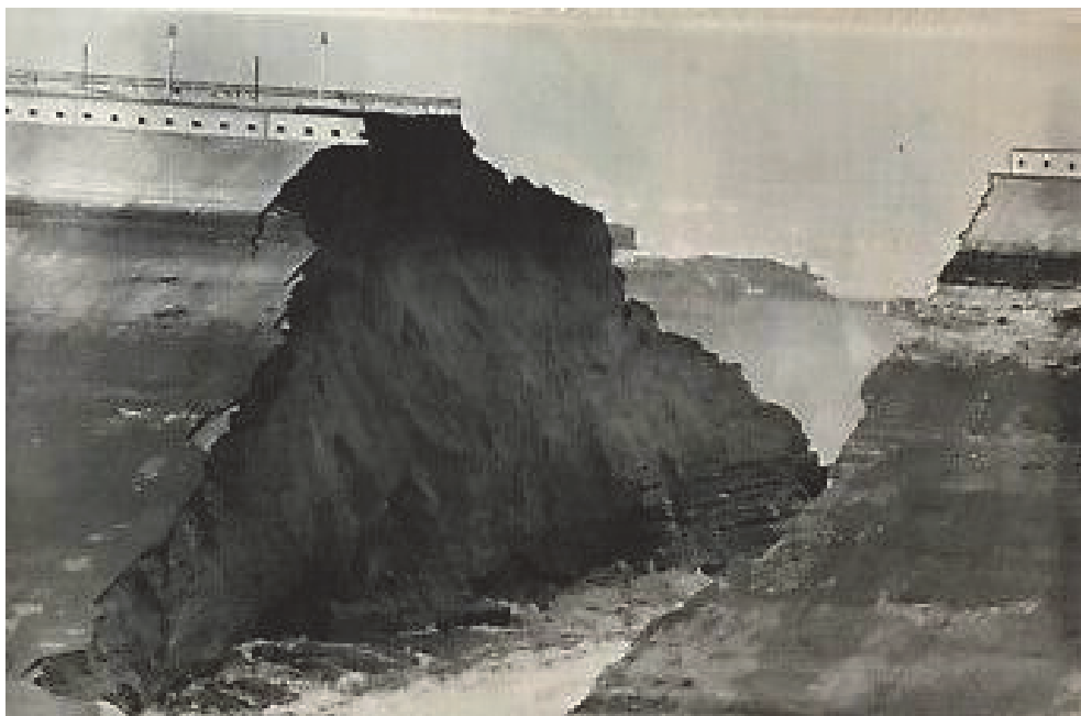
Fig. 8 – Reservatório de Baldwin Hills. Vista da brecha resultante da rotura na zona da barragem.
