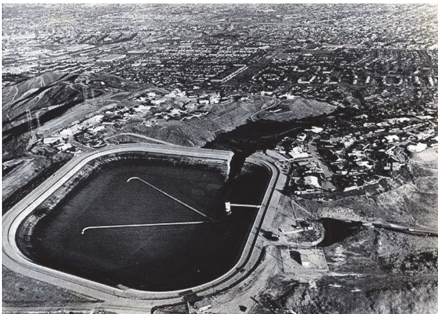
Fig. 7 – Vista geral do Reservatório de Baldwin Hills após rotura na zona da barragem, bem como da zona habitacional inundada a jusante.
