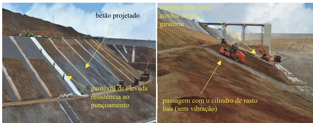
**Fig. 14** – Exemplos de regularização da superfície de apoio em curso.
