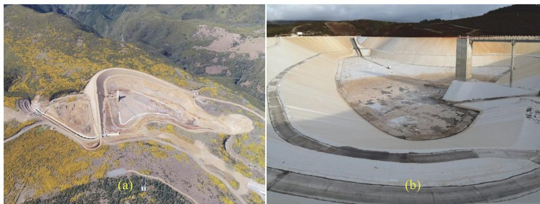
**Fig. 3** – Vista geral da obra: (a) antes da construção do sistema de impermeabilização; (b) após a construção do sistema de impermeabilização.
