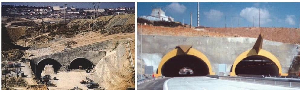
**Fig. 21** - Portal Este durante a fase de execução e portal Oeste após conclusão (Pistone e Melâneo, 1995).
