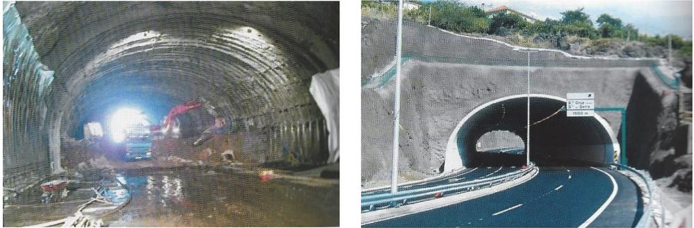
**Fig. 30** - Vistas da execução do rebaixo e do portal oeste do túnel de Santa Cruz Oeste.
