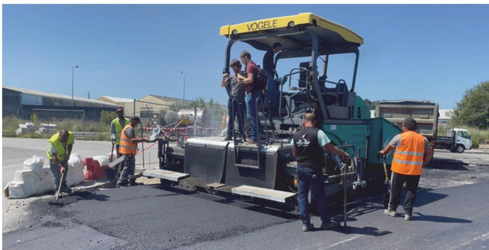
**Fig. 14** – Experiências de incorporação de uma câmara térmica em pavimentadora.
