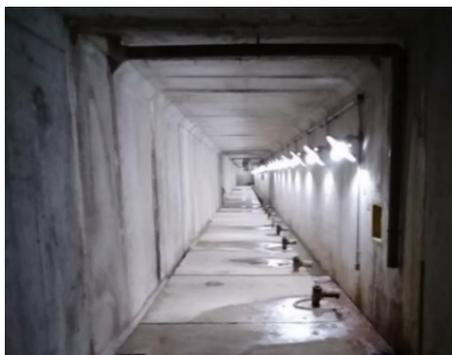
**Fig. 7** – Foto atual da galeria com detalhe dos dispositivos de saída dos drenos que compõem a cortina de drenagem.
