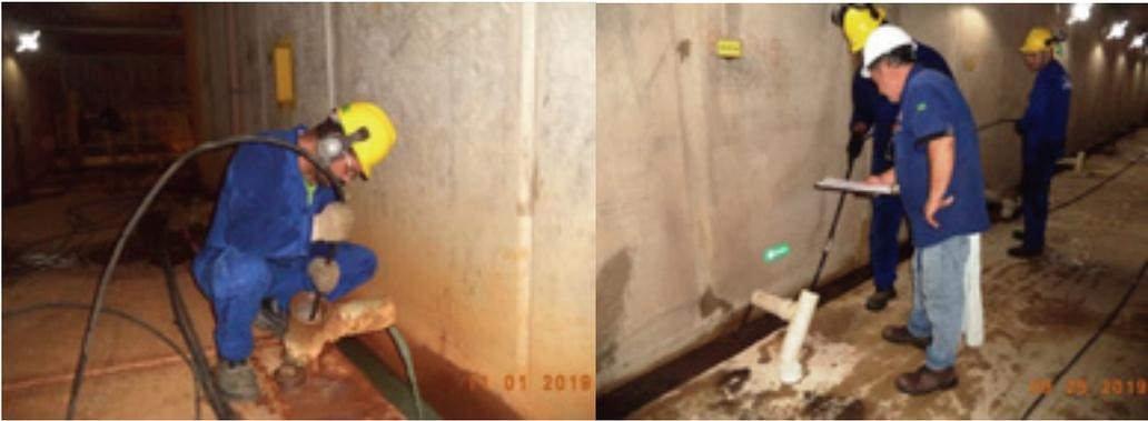
**Fig. 18** – Registros de atividade de limpeza de drens da cortina de drenagem.
