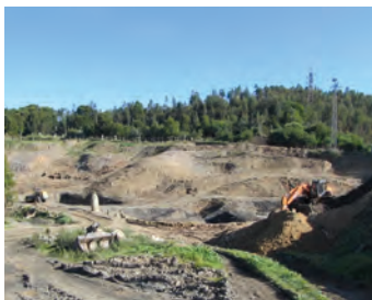
Fig. 4 – Irregularidade do terreno subjacente ao depósito de resíduos.
