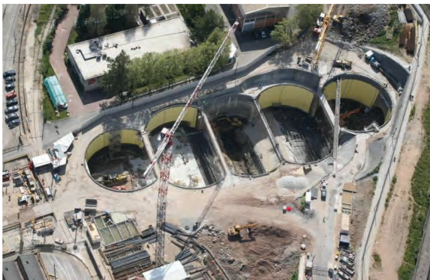
Fig. 6 – Construção da Estação da Reboleira do Metro de Lisboa (CJC, 2017).
