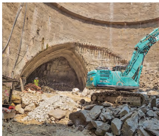
a) Início lado nascente
