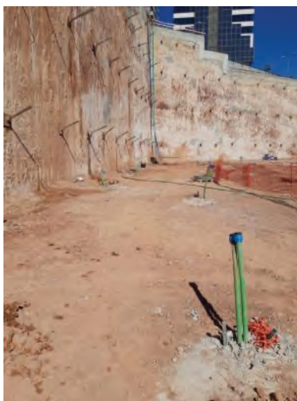
Fig. 3 – Furos geotérmicos já executados na base do fundo de escavação de um edifício de escritórios em Lisboa.
