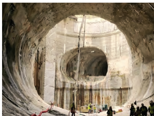
d) Vista geral após conclusão da CM
