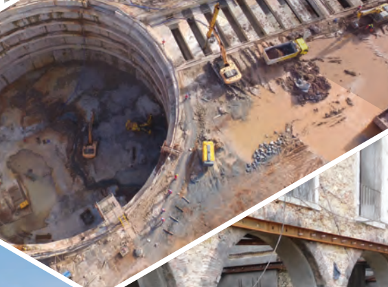
Poço de minério Kamsar, Guiné
