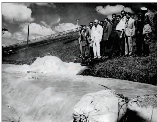
a) Inspeção visual em zona de perigo
