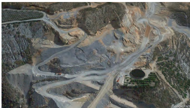
Fig. 11 – Vista de una inestabilidad en el talud durante su ejecución.
