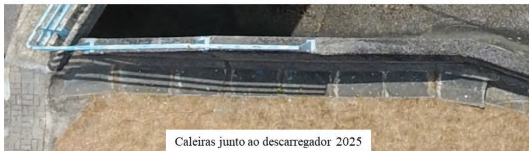
Fig. 35 – Fissuras junto ao descarregador, no talude de jusante. Comparação entre as campanhas de 2021 e 2025.
