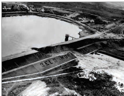
b) Rotura da barragem
