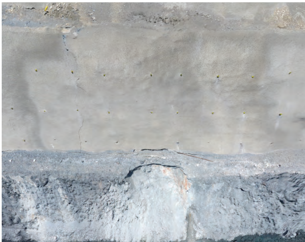
Fig. 2 – Inspeção aérea em zona de alto risco (imagem extraída de um modelo 3D texturizado, gerado a partir de imagens capturadas por drone).
