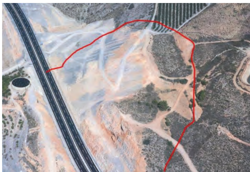
Fig. 15 – Vista del área afectada por el deslizamiento. La línea roja representa el contorno de la zona movilizada.
