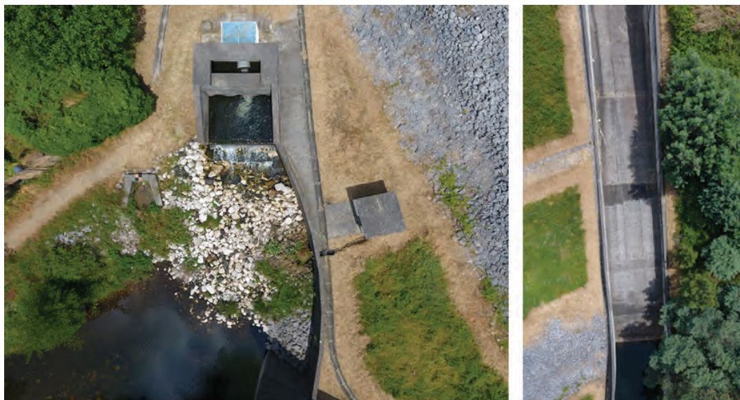
a) Zona imediatamente a jusante
