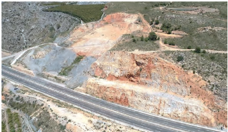
Fig. 20 – Vista del estado actual del talud en 2025.
