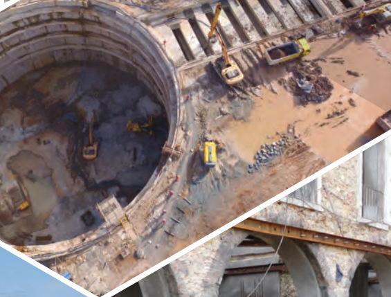
Poço de minério Kamsar, Guiné
