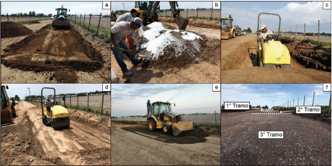
Fig. 7 – a) Escarificación y extracción de caja de suelo del tramo experimental; b) Mezcla del suelo natural con cal y silicato de sodio; c) y d) Relleno, vibrado y compactación por capas; e) Terminación del tramo 3° con agregado 0-6 mm; f) Vista de los tres tramos terminados.
