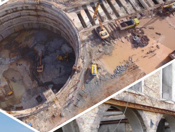
Poço de minério Kamsar, Guiné
