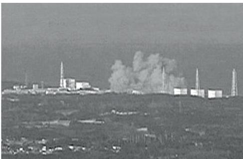
O complexo acidente nuclear de Fukushima resultou da incapacidade de controlar o processo de fissão, pelo arrefecimento do núcleo do reator, em virtude da falha energética que se seguiu ao abalo sísmico e ao tsunami.
