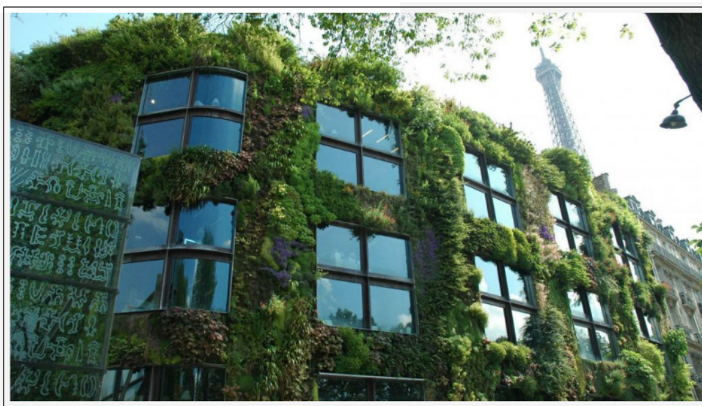
FIGURE 4 - Exemple de bâtiment aux murs recouverts de végétation
