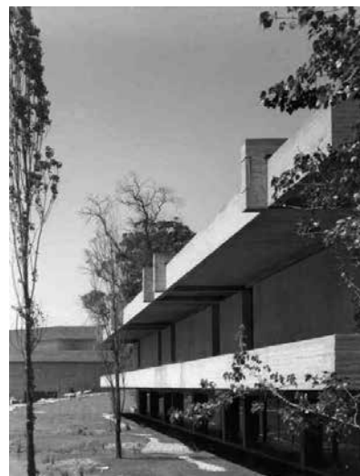
4. Alberto Pessoa, Pedro Cid e Rui Athouguia, Fundação Calouste Gulbenkian, Lisboa, Portugal, 1969. Vista do corpo do Museu e Biblioteca. Arquivo Fundação Calouste Gulbenkian. Foto Mário de Oliveira.
