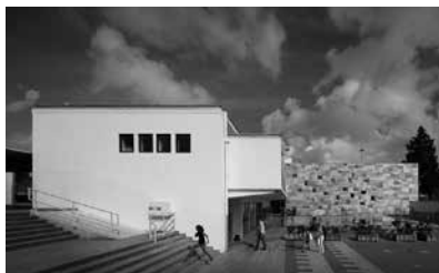
8. Otto Bartning, Deutsche Schule Lissabon, Lisbon, Portugal, 1959. Intervenção Arquitecto João Luís Carrilho da Graça, 2007-2009. Foto FG+SG Fotografia de Arquitectura, Fernando Guerra.
