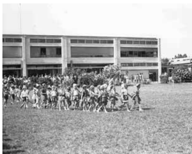
7. Otto Bartning, Deutsche Schule Lissabon, Lisbon, Portugal, 1959. Foto Revista Arquitectura.
