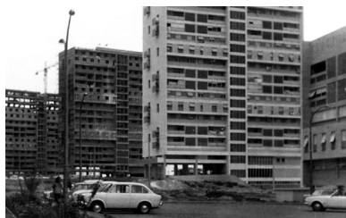
3. Unidade de Vizinhança n.º1 do Bairro Prenda em construção (Arquivo FLSC)
