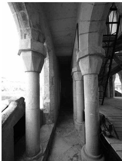
11. Pasaje situado en interior de muros de Torre Linterna
