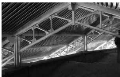
7. Restauración de la Cubierta de la Girola
