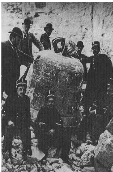
2. Situación en el exterior de la Torre del Giraldo hundida
