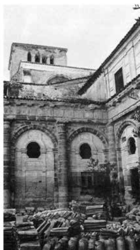
13. Situación del deterioro del Claustro al inicio de su restauración
