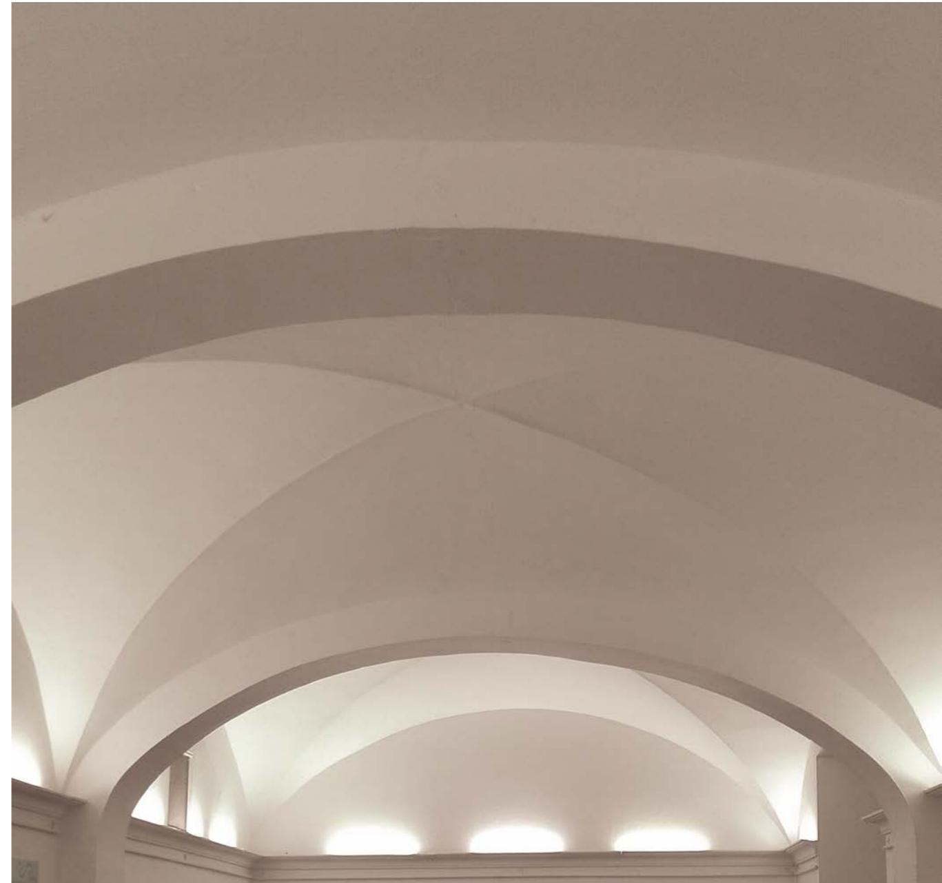
Figura 6 (à direita) - Abóbada de tijolo em Borba. © Ana Costa Rosado
