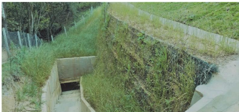
**Fig. 11** – Aterro com contenção em Terramesh Verde 2 meses após conclusão
