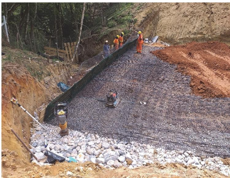
**Fig. 8** – Execução da primeira camada do Terramesh Verde, sob a base de rachão
