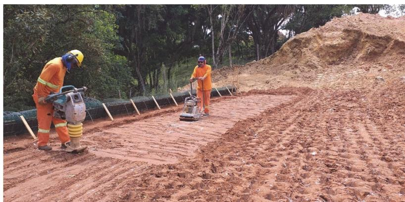
**Fig. 10** – Compactação manual próxima ao paramento frontal
