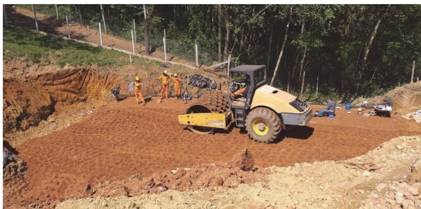
**Fig. 9** – Compactação das camadas do aterro
