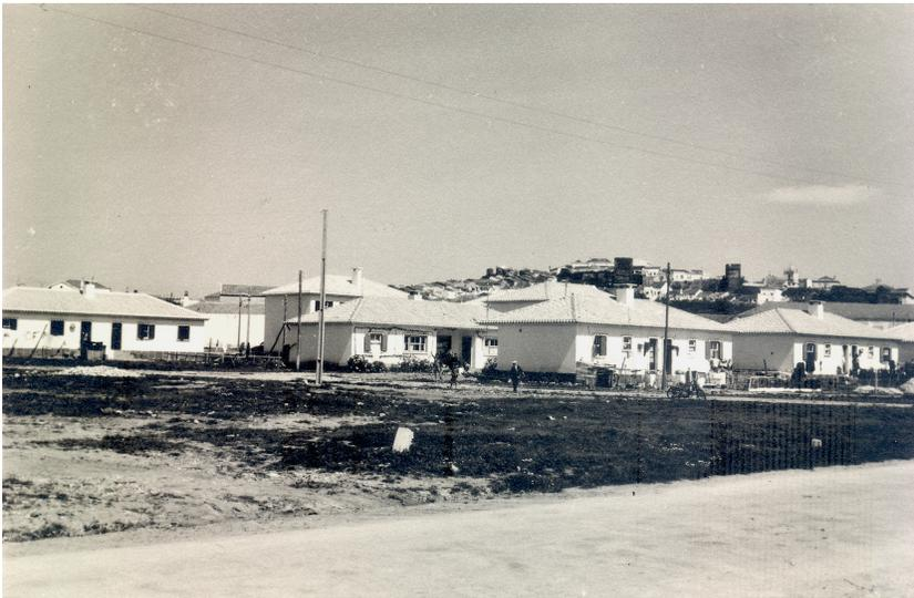
Figura 5 – Bairro de «Casas para Famílias Pobres» em Silves, vista do conjunto, s.d [post. 1959]. ©Direção-Geral do Território. A técnica construtiva de blocos perfurados de cimento revelou-se em alguns casos problemática na prática, levando ao retorno a soluções mais experimentadas tais como o tijolo vazado cerâmico, finalmente utilizado em Silves.
