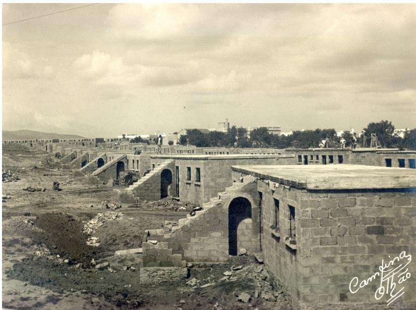
Figura 4 – Bairro de «Casas para Famílias Pobres» em Olhão, obra em curso, s.d [c. 1947]. ©Direção-Geral do Território. As casas, embora adotando uma capa evocativa das tradições construtivas locais (a açoteia, a escada exterior sobre arco, o volume edificado puro), foram realizadas com recurso a técnicas então recentes, algumas experimentais, como a laje em tijolo com vigotas pré-esforçadas e os blocos perfurados de cimento pré-fabricados em paredes.
