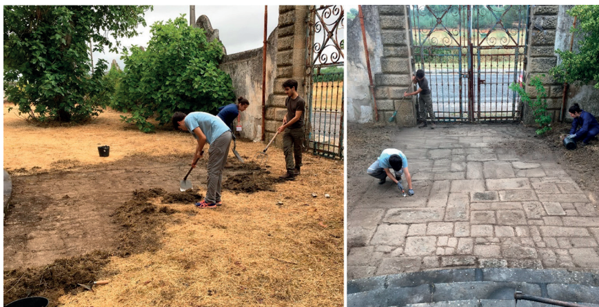
Fig. 4. Vista dos trabalhos de limpeza e desenho do empedrado de acesso à porta principal da Escola.
