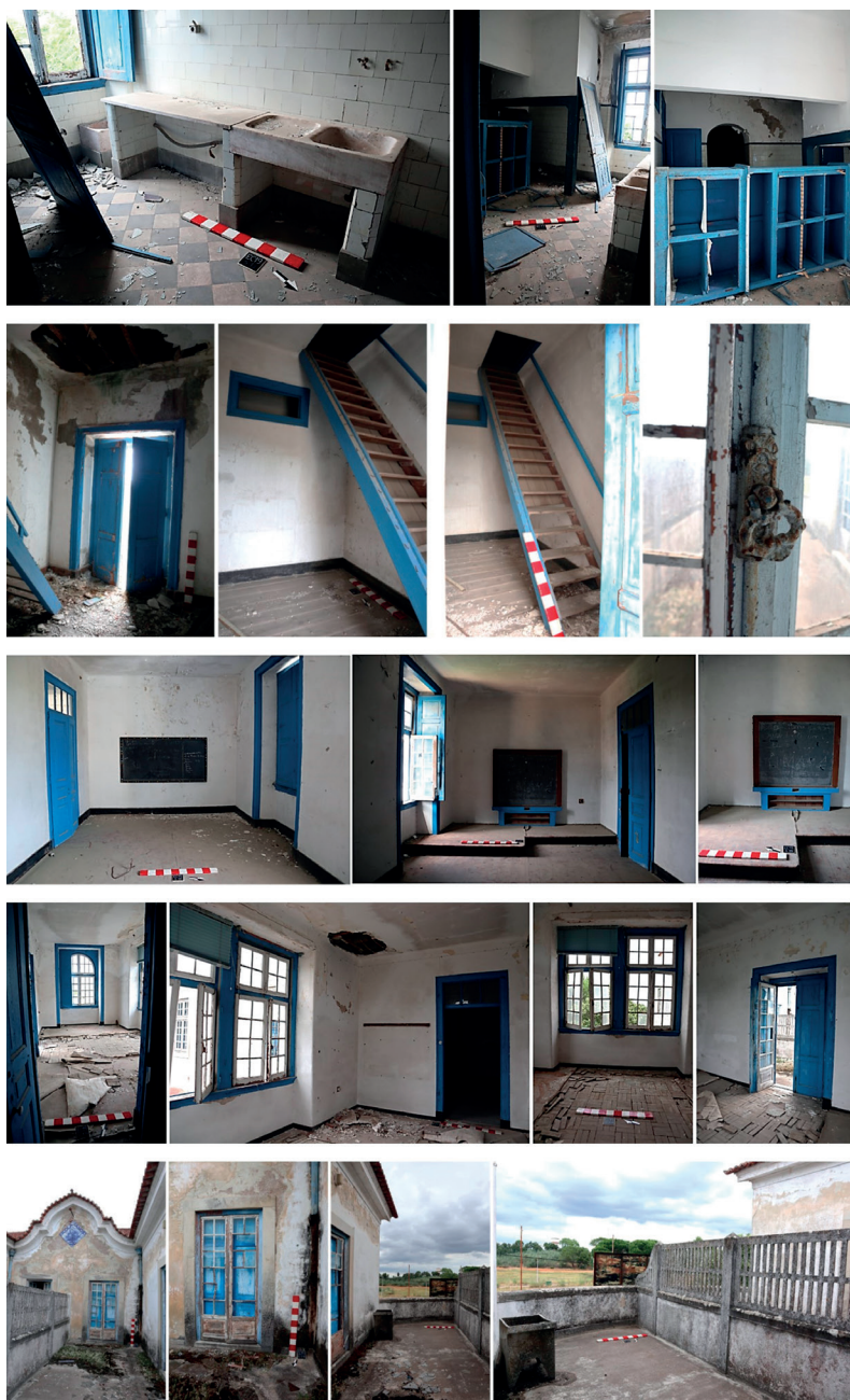
Fig. 8. Exemplos do levantamento efetuado: vistas de alguns espaços interiores (Sector) do primeiro piso da Escola (Sector 1), por ordem de linha, começando no topo: S. 1.3, S. 1.12, S. 1.15, S. 1.17, S. 1.18b.
