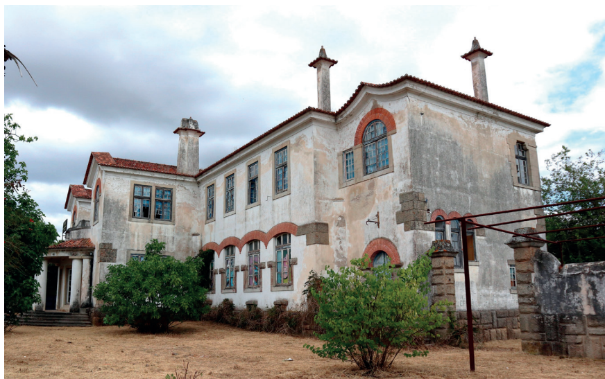
Fig. 2. Vista da Escola a partir do Jardim Oeste, aquando dos trabalhos.
