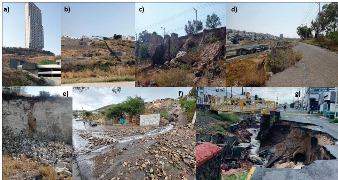
**Fot. 1** - Evidencias de inestabilidad del terreno asociada al crecimiento urbano: a) Edificio en borde de ladera terraseada, b) Ladera con terrazas y gaviones, c) Deslizamiento rotacional, d) Vista superior del deslizamiento rotacional, e) Bloques colapsados en ladera modificada, f) Flujo de escombros (Noticias de Querétaro, 2022), g) Subsidencia del terreno (Expreso Press, 2021).
