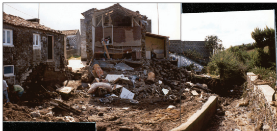
Fot. 17 - Casa localizada no leito e cheia de uma linha de água que foi destruída - Ponta Garça (S. Miguel, 1998).
