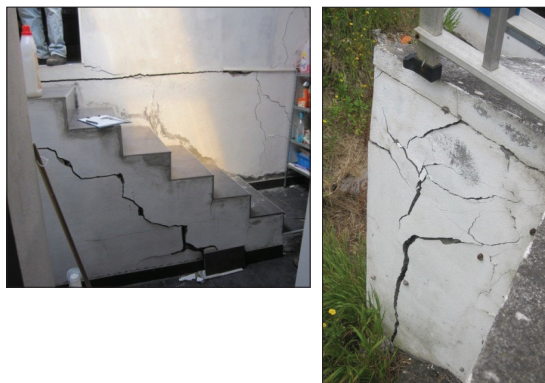
Fot. 15 - Patologias associadas à rotura de canalização de água que causou a instabilização do terreno.
