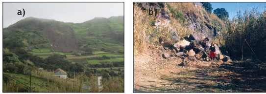
Fot. 10 - Deslizamento ocorrido entre dois taludes de escavação na ilha das Flores (a) e queda de blocos na sequência da remoção do depósito de vertente existente na base do talude (b) (Vila Franca do Campo, 1987).
