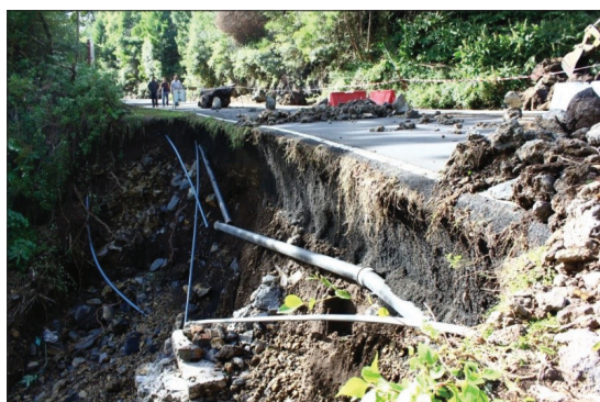
Fot. 20 - Destruição provocada pelo transbordo de água e detritos e consequente instabilização de taludes de aterro.
