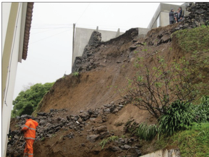
Fot. 11 - Talude que instabilizou em S. António (S. Miguel, 2012), fragilizado pela sobrecarga resultante da construção de uma casa (a), e redução do fator de segurança em função da sobrecarga (b).
