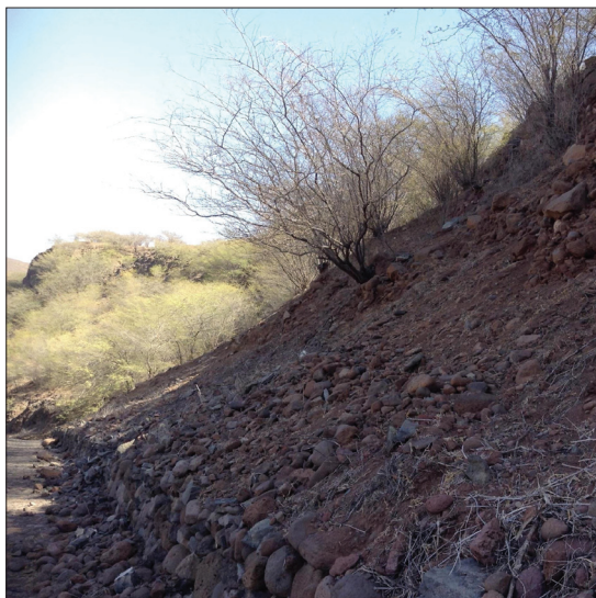
Fot. 4 - Fluxo de detritos a seco, por aproximadamente 250 metros na estrada calçetada (principal) (Fonte: Autores, 2015).
