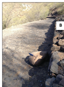
Fot. 6 - Risco de acidentes associados a movimentos em massa na estrada da localidade (A); Quedas de blocos (B) Tombamentos (Fonte: Autores, 2015).
