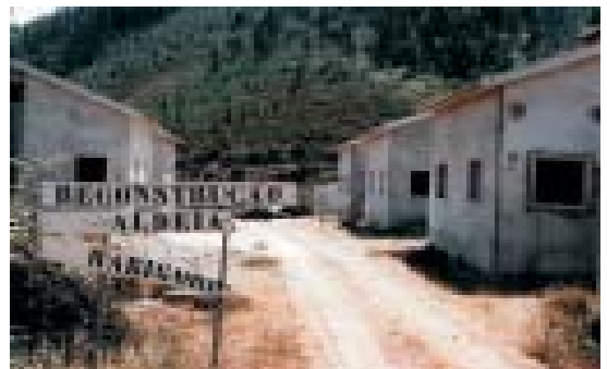
Fot. 5 - Aspecto de Rabigordo, em 1991, durante a fase de interrupção das obras de reabilitação da aldeia, oito anos após o incêndio que, em 1983, a tinha devastado.
