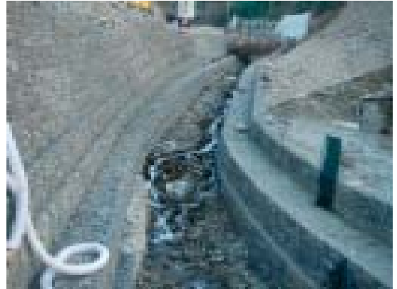
Fot. 16 – Pormenor da execução das obras na área do antigo parque de estacionamento. Fot.: Eng.ª Carla Neves, Cãm. Mun. Arganil.
