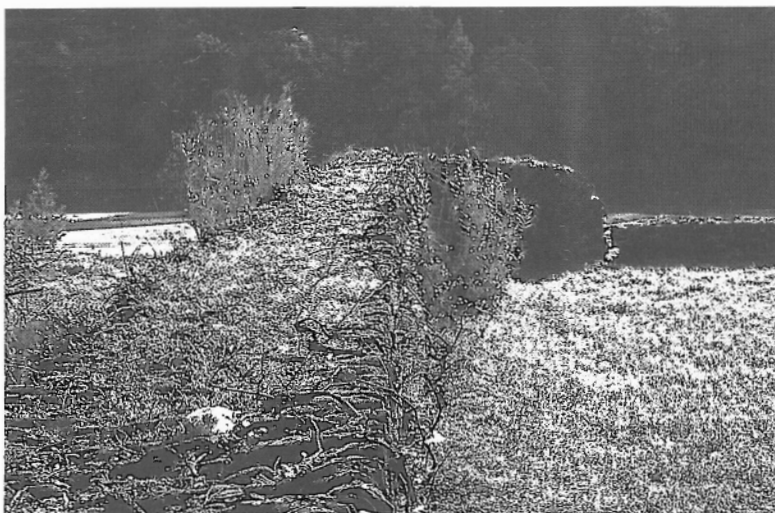
Photo 4 - Mondego, rive droite, en amont de Coimbra. Détail d'un mur transversal en schiste bâti sur le lit d'inondation.
