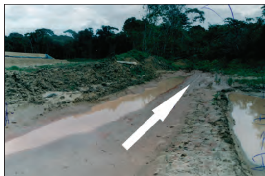
Fot. 4 - Cava executada para conter o vazamento (Fonte: CPC, 2003a, modificado com o acréscimo da seta).
