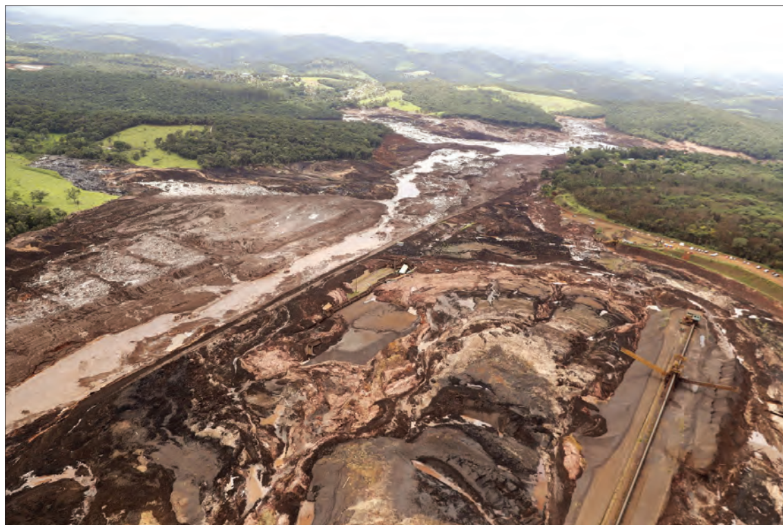
Fot. 2 - Rompimento da barragem de rejeitos de mineração de Brumadinho (Fonte: G1 Globo, 2019, link: www.g1.globo.com/mg/minas-gerais/noticia/2019/03/14/apos-desastre-de-brumadinho-mais-de-mil-pessoas-largam-casas-e-estao-sem-previsao-de-retorno.ghtml ).
