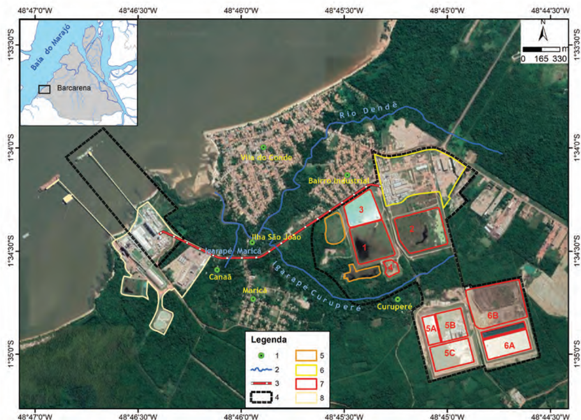
Fig. 6 - Imerys, em 2019: 1 - Localidades; 2 - Rede hidrográfica; 3 - Mineroduto; 4 - Área sob responsabilidade da mineradora; 5 - Área adicional de Contenção; 6 - Planta de Beneficiamento; 7 - Bacias de Rejeitos n.º 1, 2, 3, 4, 5A, B e C, 6A e B; 8 - Área Portuária (Fonte: Google Earth Pro 7.3.2.5776, 2019).
