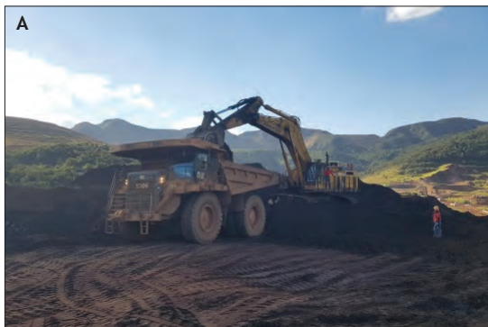
Fot. 24 - Presença massiva de máquinas pesada na retirada do rejeito de mineração liberado com o rompimento da barragem I da Mina Córrego do Feijão (a); Ferragens retorcidas de uma composição de trem de carga utilizada pela empresa VALE, atingido pela avalanche de lama de rejeito de mineração (b), 24/06/2019.
