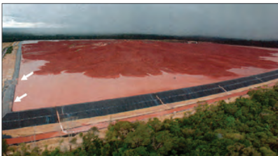
Fot. 6 - Locais de transbordamento assinalados pelas setas na bacia de contenção de rejeitos (Fonte: CPC, 2009a) Photo 6 - Overflow sites marked by arrows in the tailings containment basin (Source: CPC, 2009a).
