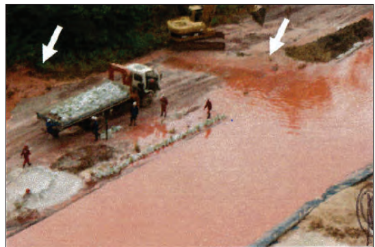
Fot. 7 - Ponto 01 do transbordamento do canal de drenagem (Fonte: CPC, 2009a).
