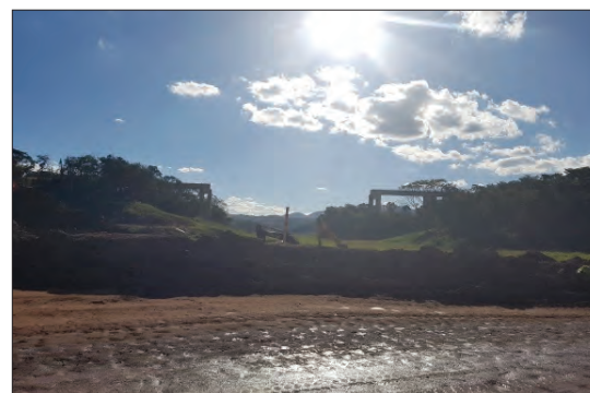
Fot. 23 - Pontilhão parcialmente destruído pela propagação da lama de rejeito de mineração liberada após o rompimento da barragem I da Mina Córrego do Feijão, em Brumadinho, 24/06/2019.
