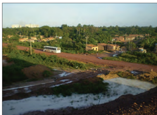
Fot. 13 - Vista do alto da bacia de rejeitos n.º 3 e a pista de rolamento que a separa do bairro Industrial (Fonte: Lemos, 2018).
