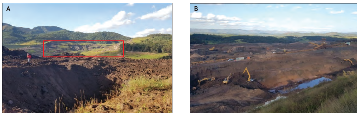
Fot. 26 - Vista da parede da barragem I da Mina Córrego do Feijão rompida em 25 de janeiro de 2019 (a); Aspetto em que ficou o terminal de carga da empresa VALE, que foi completamente destruído pela avalanche de lama de rejeito de mineração após o rompimento da barragem I da Mina Córrego do Feijão (b), 24/06/2019.
