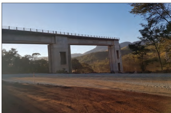
Fot. 23 - Pontilhão parcialmente destruído pela propagação da lama de rejeito de mineração liberada após o rompimento da barragem I da Mina Córrego do Feijão, em Brumadinho, 24/06/2019.
