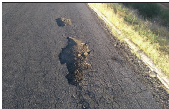
Fot. 8 - Afundamentos e falhas no pavimento da RN-188 sobre a barragem (Fonte: Adaptado de Santos, 2019).
