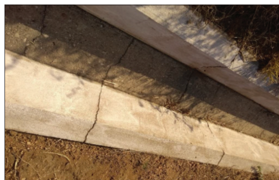
Fot. 9 - Anomalias no sistema de drenagem da RN-188 sobre a barragem Itans (Fonte: Adaptado de Santos, 2019).
