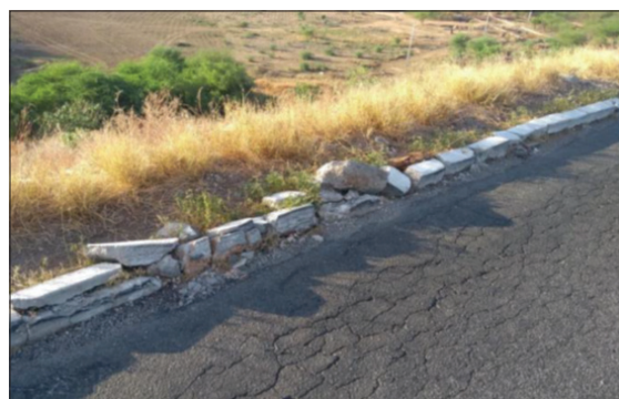
Fot. 9 - Anomalias no sistema de drenagem da RN-188 sobre a barragem Itans (Fonte: Adaptado de Santos, 2019).
