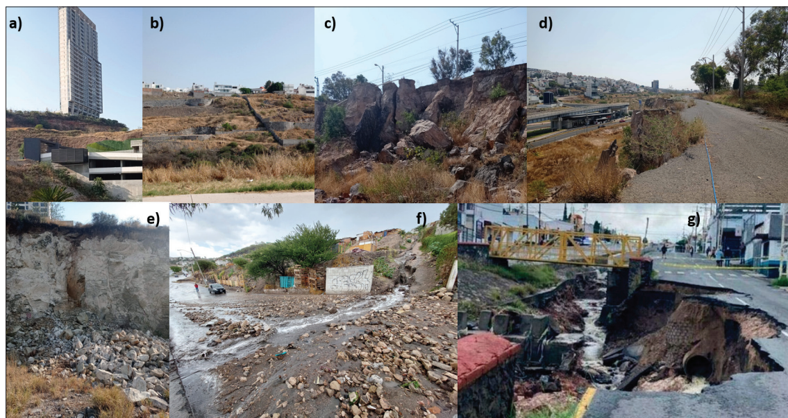
Fot. 1 - Evidencias de inestabilidad del terreno asociada al crecimiento urbano: a) Edificio en borde de ladera terraceada, b) Ladera con terrazas y gaviones, c) Deslizamiento rotacional, d) Vista superior del deslizamiento rotacional, e) Bloques colapsados en ladera modificada, f) Flujo de escombros (Noticias de Querétaro, 2022), g) Subsidencia del terreno (Expreso Press, 2021).
