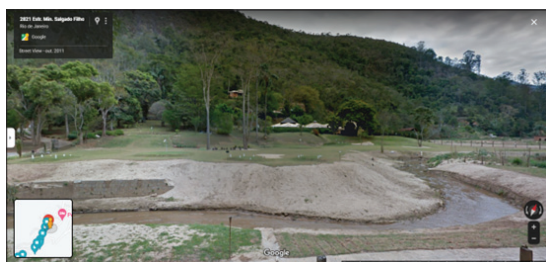
Fig. 14 - Rio Cuiabá no Ponto 20, em 2011, com obras de contenção e revegetação por gramíneas nas margens, calha do rio reconfigurada artificialmente e campo de golfe construído (Fonte: Street View, 2011).
