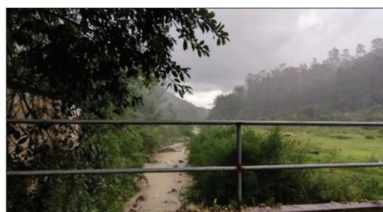
Fot. 13 - Rio Cuiabá no Ponto 31, em 2023, sentido jusante, com calha e margens revegetadas e ponte reformada (Fotografia de Rosângela Botelho, tirada a 23/01/23).
