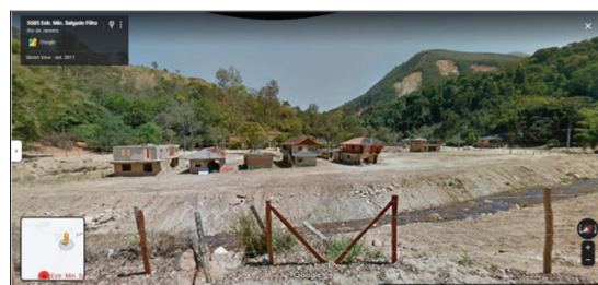
Fig. 18 - Rio Cuiabá no Ponto 30, em 2011, com acúmulo de sedimentos na planície, nivelamento do terreno, cicatrizes de deslizamentos das altas encostas e calha reconfigurada artificialmente (Fonte: Street View, 2011).
