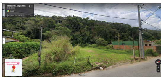
Fig. 10 - Planície do rio Cuiabá no Ponto 9, em 2011, com construções destruídas pela corrida de lama, demolidas ou em reforma (Fonte: Street View, 2011).
