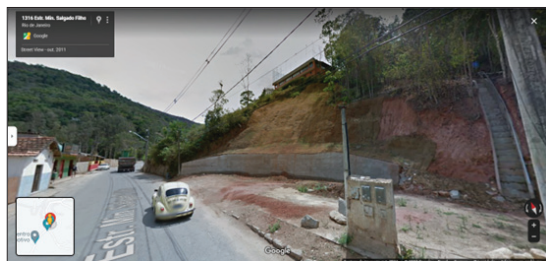
Fig. 12 - Planície do rio Cuiabá no Ponto 12, em 2011, com encosta com sinais de erosão e obras com muros de contenção (Fonte: Street View, 2011).
