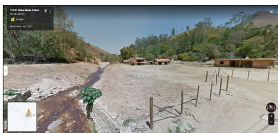
Fig. 19 - Rio Cuiabá no Ponto 31, em 2011 (sentido jusante), com a calha do rio reconfigurada artificialmente, leito assoreado, margens desprotegidas e com obras de contenção próximas à ponte (Fonte: Street View, 2011).
