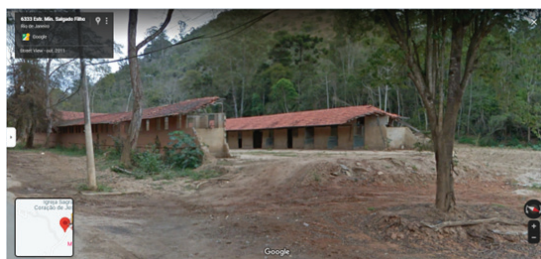
Fig. 16 - Estábulo na planície do rio Cuiabá no Ponto 23, em 2011, parcialmente destruído e soterrado pela quantidade de sedimento que foi depositada na planície (Fonte: Street View, 2011).
