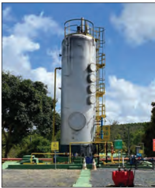
Fot. 1 - Vaso acumulador de condensado (Fotografia do arquivo dos autores, tirada em 25/04/2022).
