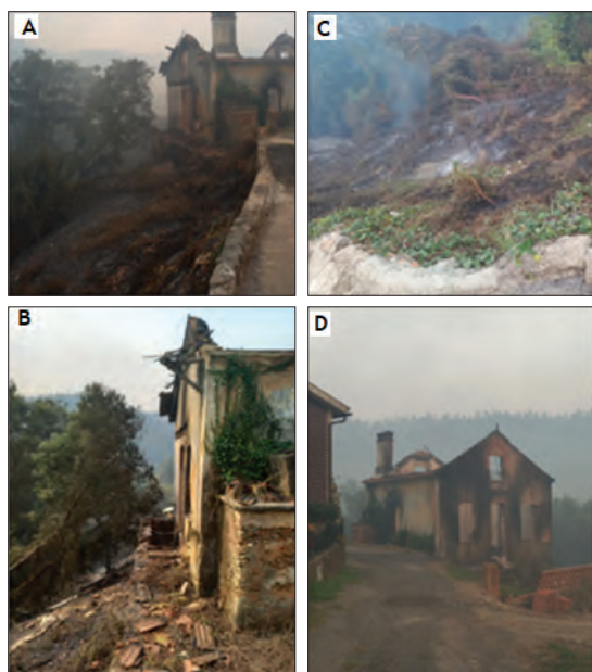
Fot. 5. -Casa após o incêndio (Fonte: autor, tirada a 16/09/2024).
