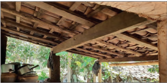
Fot. 1 - Caibros de caboatã ( Cupania impressinervia ) e praíba ( Simarouba amara ) em residência rural na Zona de Amortecimento (Fotografia de Jean Oliveira Campos, tirada em 06/07/2021).
