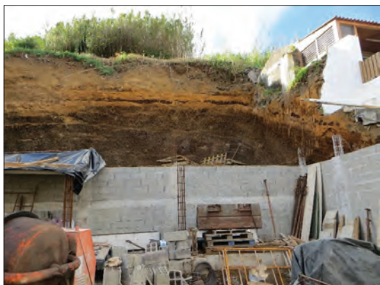
Fot. 14 - Exemplo de um muro de alvenaria a ser contruído com função de estrutura de suporte.
