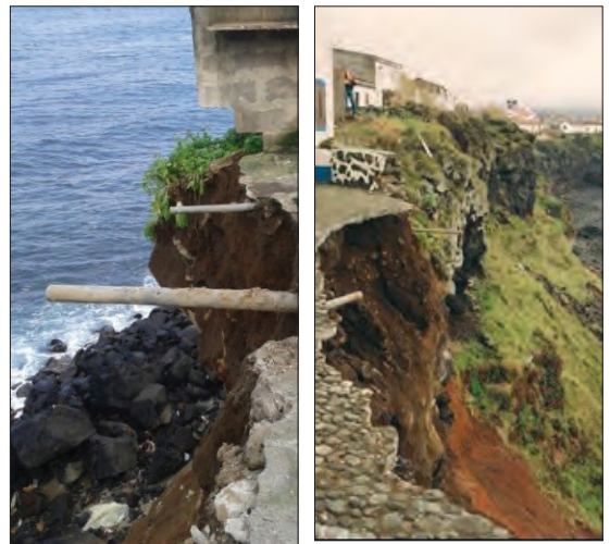
Fot. 12 - Instabilidades na orla costeira das Calhetas (S. Miguel) aceleradas pela presença de tubos de drenagem de águas residuais.
