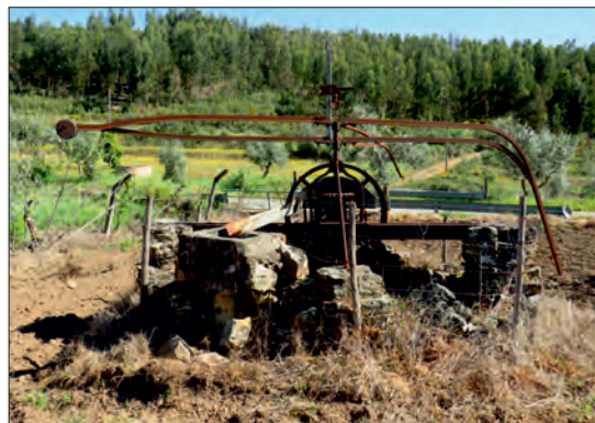
Fot.10 - Guarda-corpos em alvenaria de pedra, como prolongamento interior do Poço (Fotografia de Susana Serrão, tirada em 2023).
