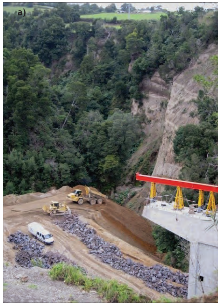
Fot. 22 - Estrangulamento de uma linha de água por aterro para obras de construção de um viaduto (Ribeira Chã, ilha de São Miguel, 2010) (a) e inundações causadas por alteração do uso dos solos, a montante, por arroteamentos na freguesia das Feteiras em 2021 (b).
