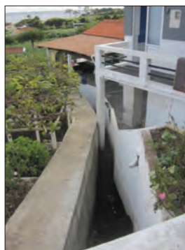
Fot. 21 - Entupimento do canal de escoamento na Ribeirinha, Lajes do Pico.
