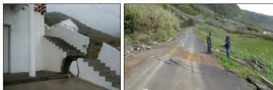
Fot. 8 - Danos numa moradia e numa estrada, devido à cedência do solo de fundação causada pela rotura do terreno (S. Maria, 2010).
