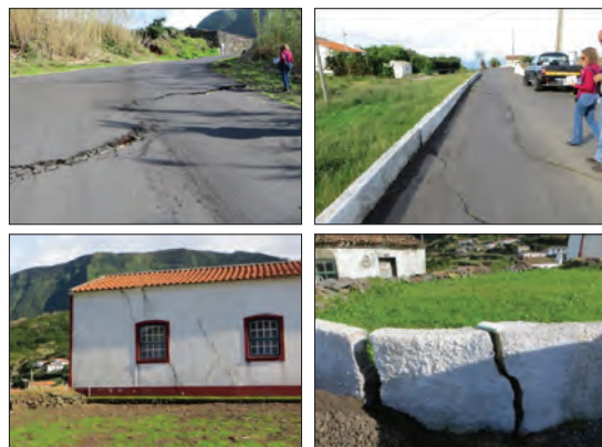
Fot. 9 - Aspeto de algumas fendas observadas nas construções e na estrada (Fajãzinha, Flores).
