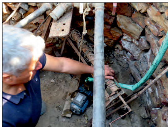
Fot. 11 - Motor elétrico para sucção da água do poço artesanal (Fotografia de Susana Serrão, tirada em 2023).
